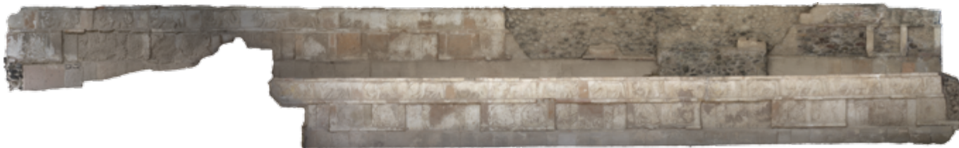
FIGURA 3. Vista general de la fachada este del Edificio B (Imagen: Archivo fotográfico del Proyecto Tula, 2016; cortesía: Coordinación Nacional de Conservación del Patrimonio Cultural [CNCPC-INAH], México).
