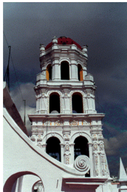
FIGURA 11. Torre norte restaurada (Fotografía: Acrosa, 1999; cortesía: Empresa constructora Acrosa).
