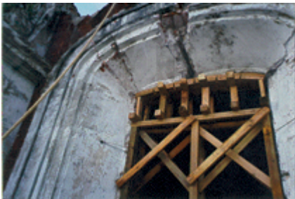
FIGURA 7. Apuntalamiento de madera en el vano del luneto (Fotografía: Acrosa, 1999; cortesía: Empresa constructora Acrosa).
