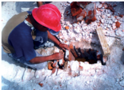
FIGURA 8. Reposición de material constructivo en las grietas de las bóvedas (Fotografía: Acrosa, 1999; cortesía: Empresa constructora Acrosa).
