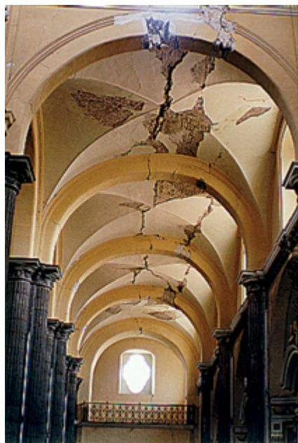
FIGURA 3. Grietas en la bóveda sur del edificio (Fotografía: Acrosa, 1999; cortesía: Empresa constructora Acrosa).
