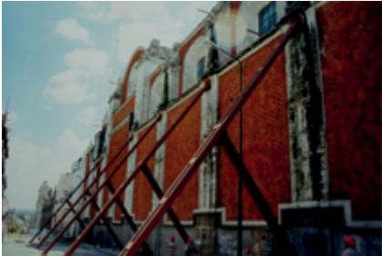
FIGURA 6. Apuntalamiento de acero de la fachada norte (Fotografía: Acrosa, 1999; cortesía: Empresa constructora Acrosa).
