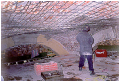
FIGURA 9. Colocación de la capa de aplanado armado en las bóvedas (Fotografía: Acrosa, 1999; cortesía: Empresa constructora Acrosa).
