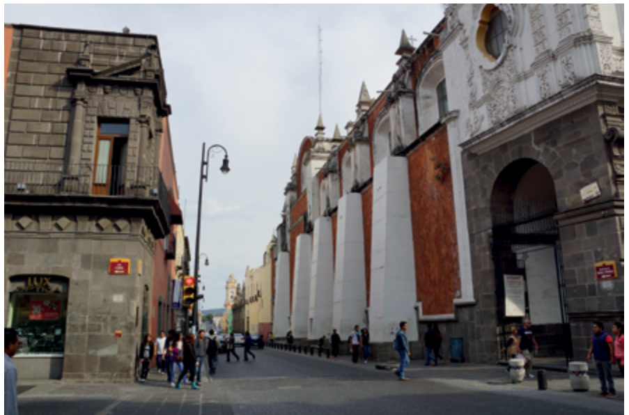
FIGURA 13. Contrafuertes metálicos cubiertos con tablarroca (Fotografía: Mariano Castellanos Arenas, 2016).
