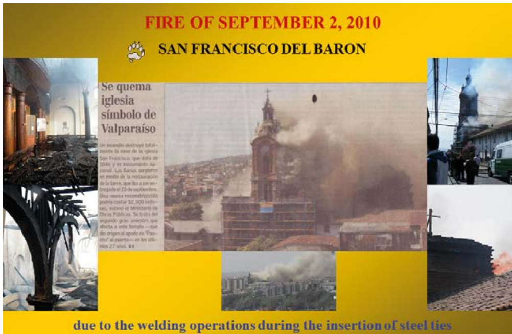
Figura 7: Incendio de 2010 que afectó a la Iglesia de San Francisco del Barón.
