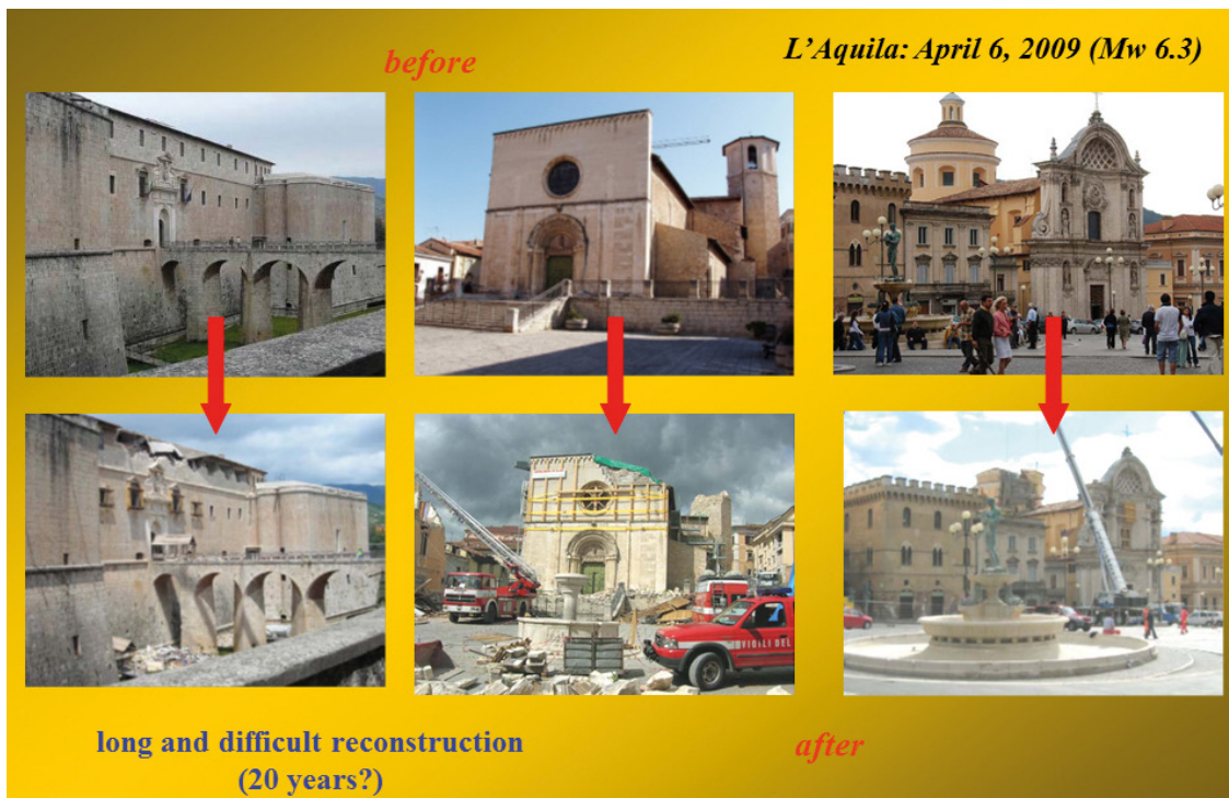
Figura 2: Danos patrimoniais em L'Aquila após o evento sísmico de 2009.
