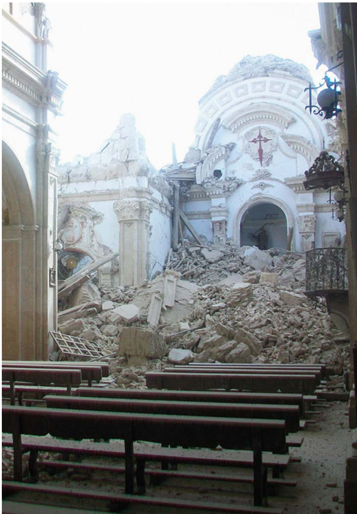
Figura 2- O terremoto ocorrido em Lorca, em 11 de maio de 2011, causou, entre outros desastres, o afundamento da abóbada da Igreja de Santiago.
