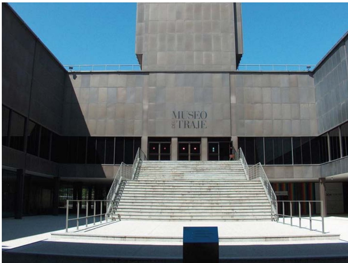
Figura 3- Os materiais de construção e a localização do edifício do museu podem constituir fatores de risco a serem considerados.
