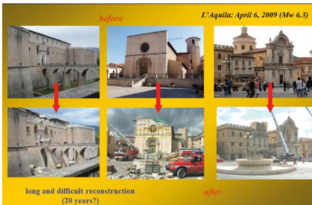
Figura 2: Patrimonio dañado en L'Aquila luego del evento sísmico de 2009.
