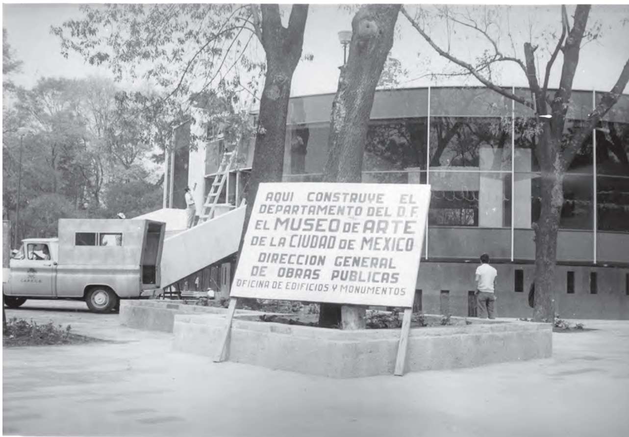
El museo en construcción Fotografía © Archivo fotográfico del Museo de Arte Moderno, INBA
