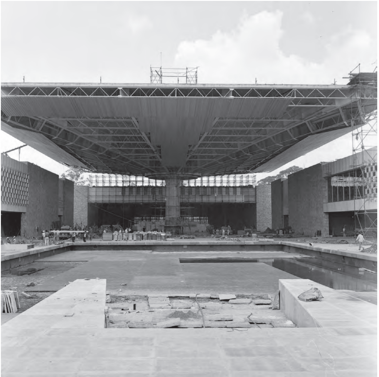
Patio principal del Museo Nacional de Antropología durante su construcción (1963-1964) Fotografía © Sinafo-INAH, inv. 228775
