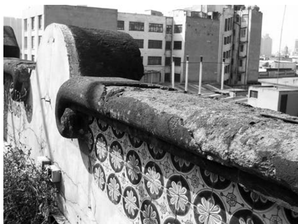
Detalle de elementos arquitectónicos sin recubrimiento Fotografía © Mariana López
