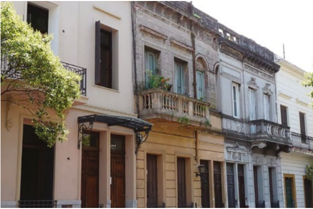
Imagen 7A. Vivienda en propiedad horizontal, edificaciones de planta baja y un piso.
