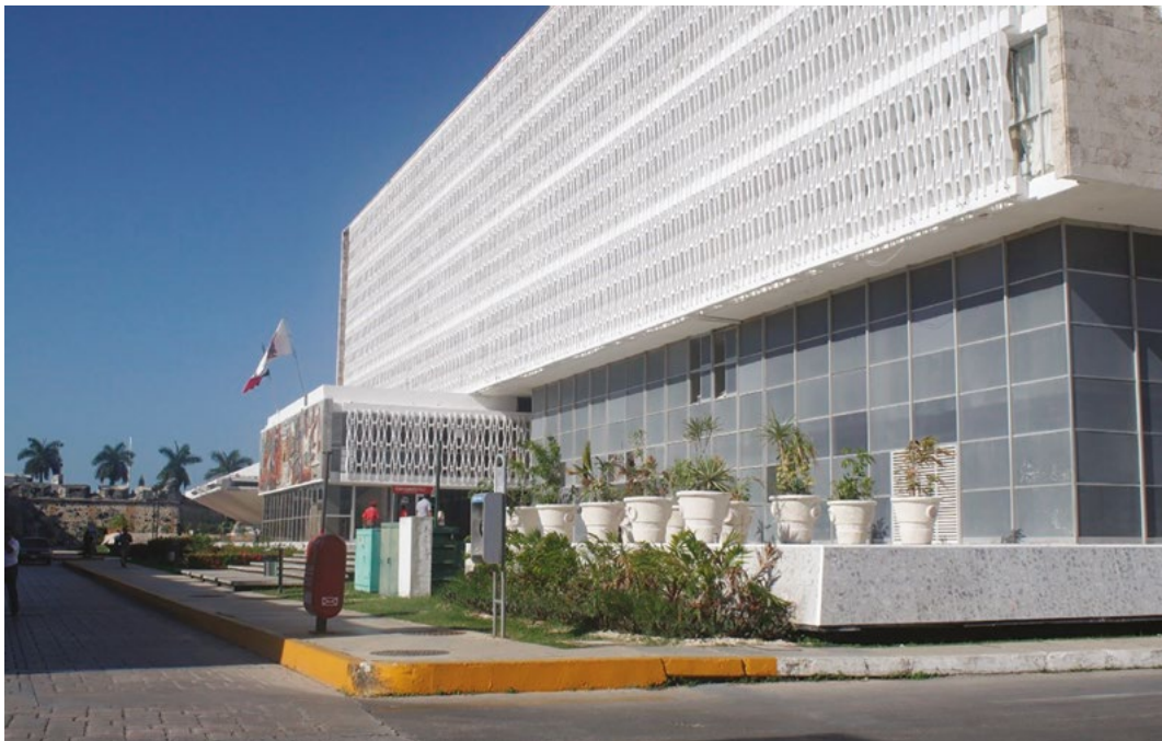
Imagen 10. Edificio de los tres poderes. Fuente: Foto MCC.
