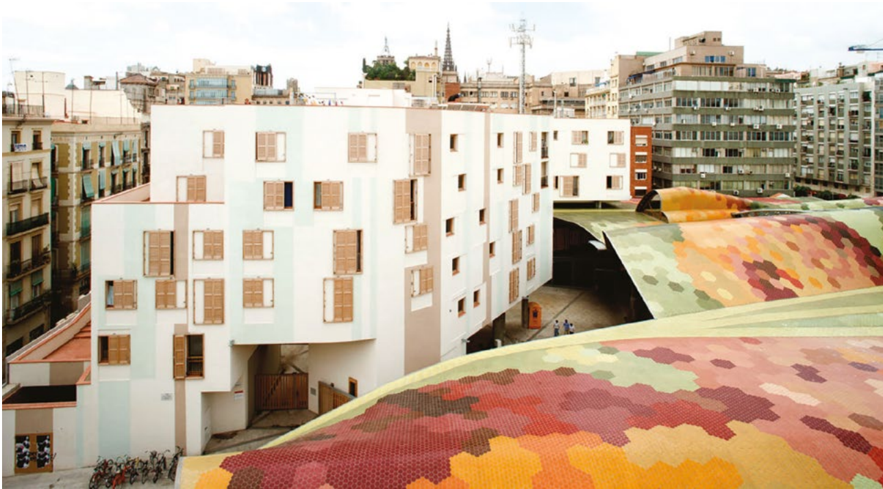
Imagen 38. Edificio de 59 viviendas tuteladas para personas de la tercera edad, en el ámbito del mercado de Santa Caterina.
