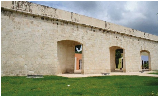
Imagen 19. Sección reconstruida de la muralla.
