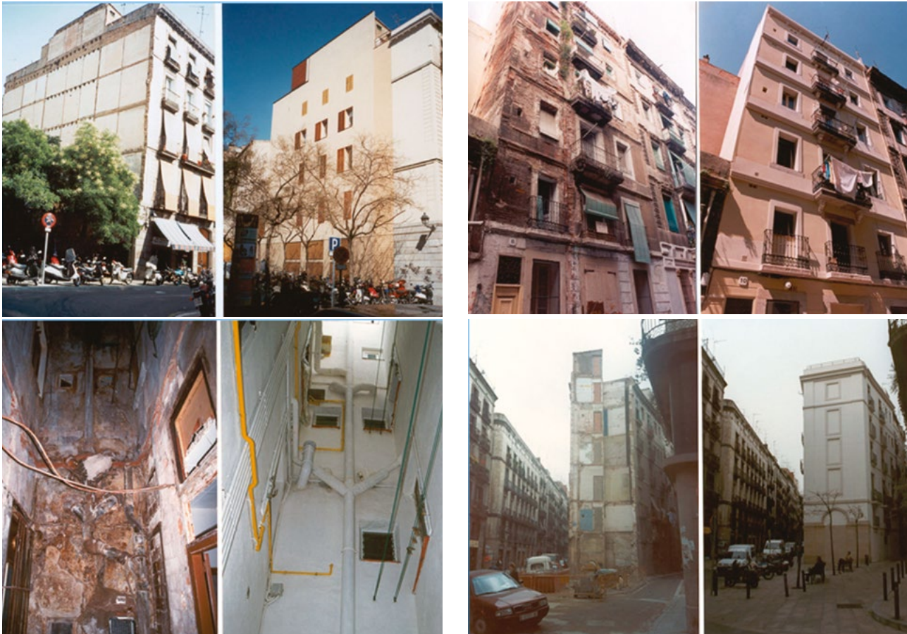
Imagen 29. Serie de fotografías de la intervención en mejora de edificios residenciales.
