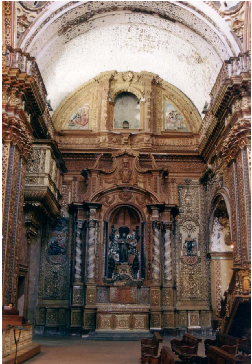
Vista general del retablo de San Francisco Javier en el transepto norte de la iglesia, tras la reconstrucción de las partes dañadas por el incendio y antes de la aplicación de la capa de dorado.
