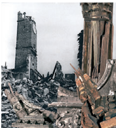
Mayo de 1976. El altar mayor de Santa Maria del Giglio desmoronado tras el derrumbe de la iglesia circundante. Sus piezas rotas permanecieron bajo los escombros unos diez días.
