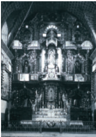
1920 Fotografía del retablo después de algunas modificaciones sufridas en la calle central, tras el incendio.
