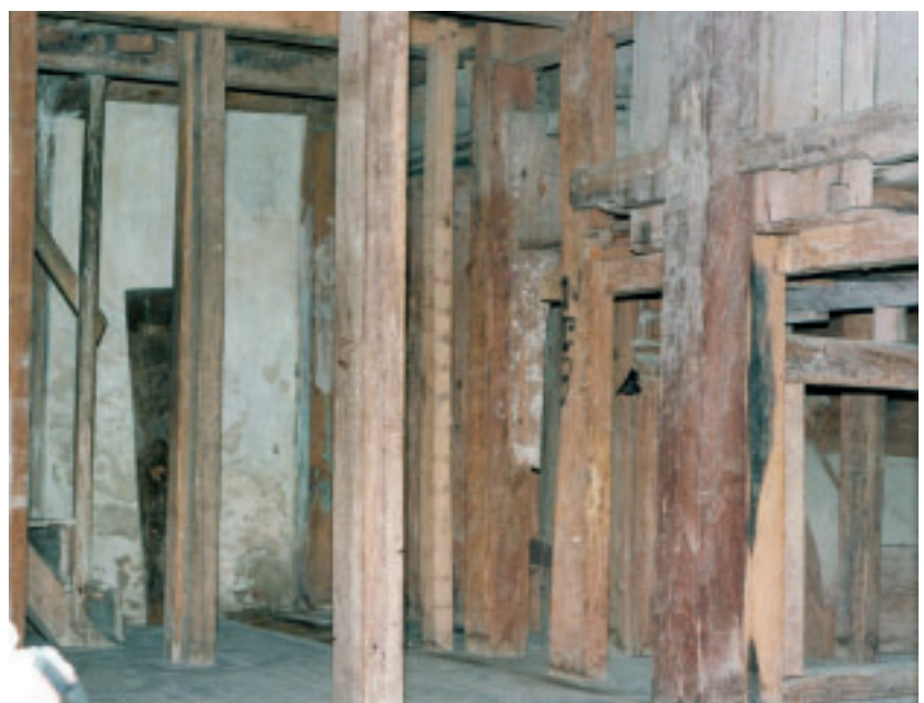
Parte posterior del retablo mostrando parte de su estructura.
