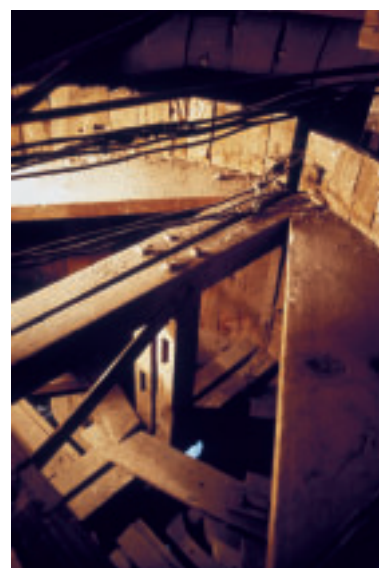
Estructura del remate.
