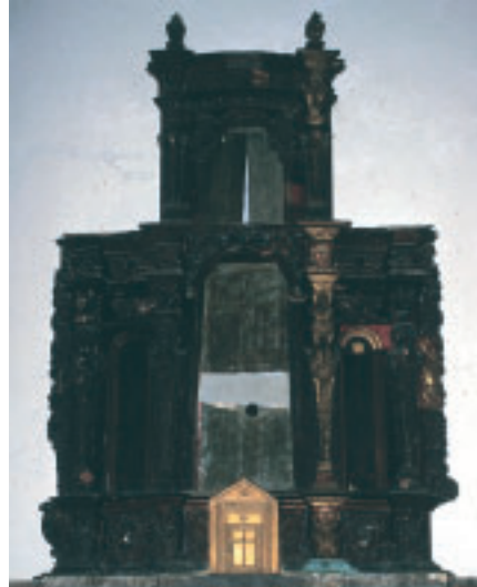
Vista general del retablo, antes y después de la intervención.
