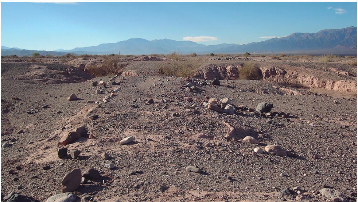
Figura 7. Estructura arquitectónica con cimientos de piedra de época incaica. Se advierte su destrucción casi completa. Al fondo de la imagen se observa una gran torrentera que atraviesa el área (Fotografía: Carosio, S. 2007). Architecture structure with stone foundations from inca period. It can be noticed that it is almost completely destroyed. At the bottom of the photograph a great gully which crosses the area is observed (Photography: Carosio, S. 2007). Estrutura arquitetônica com fundações de pedra do período incaico. Nota-se a sua destruição quase completa. Ao fundo da imagem observa-se o leito do rio que atravessa a área (Fotografia: Carosio, S. 2007).
