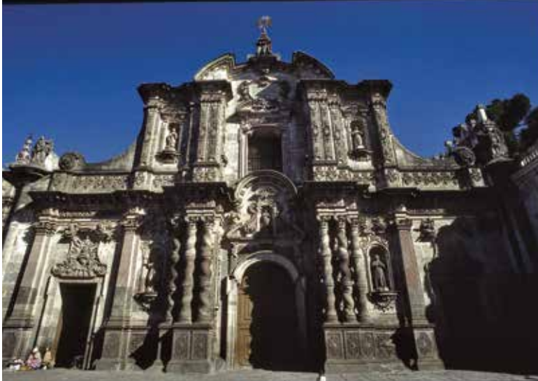
Facha de la iglesia de la Compañía de Jesús, construida de 1722 – 1725 y de 1760 – 1765. [CH/IMP].
