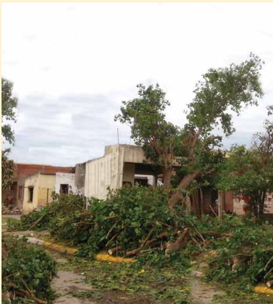
Daños en las viviendas causados por el vendaval del año 2010.
