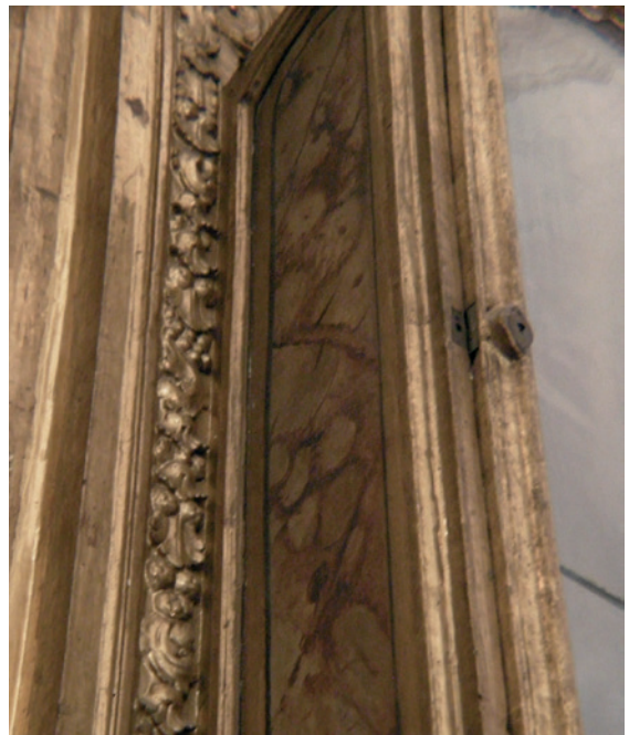
Figura 8. Imitación de las vetas de los mármoles mediante el jaspeado. Retablo lateral del templo de La Enseñanza. México, D.F. (Fotografía: Cordero, A. 2012). Imitation of marble veinings through speckles. Lateral altarpiece from La Enseñanza Temple. México, D.F. (Photograph: Cordero, A. 2012).
