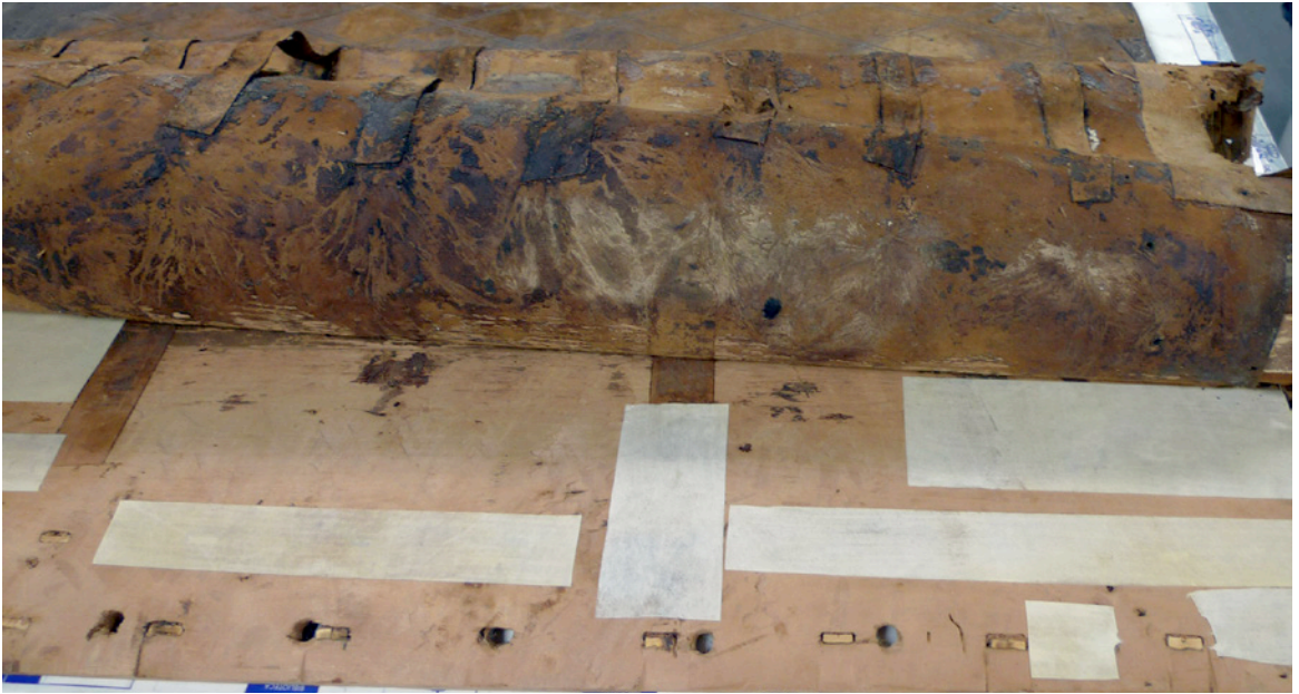
Figura 6. Se reforzaron todas las grietas de la madera con tiras de pergamino nuevo pegadas con gelatina. Intervención de uso común hasta el siglo XVII, demostrando su eficacia frente a otros métodos de tratamiento de la madera. Los listones transversales de refuerzo fueron colocados en la segunda encuadernación (Fotografía: Crespo, L. 2014. Archivo Biblioteca Nacional de España, BNE-MpCant/ 23_003).
