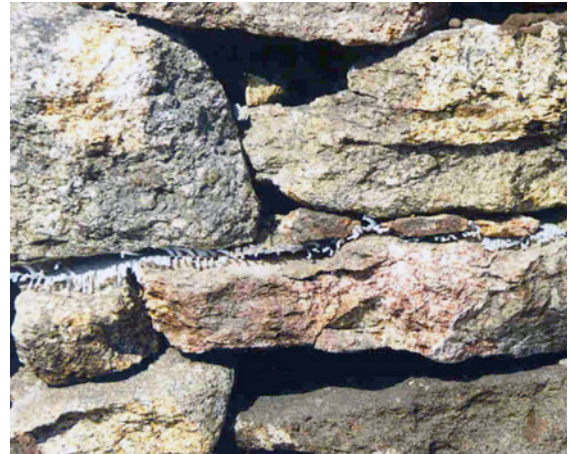
Figura 6. División entre el muro preexistente y la parte reconstruida, mediante fibra de geotextil sintético en una de las estructuras del poblado de Cossourado (Fotografía: Silva, M. de F. M. da 2013). Separation between the preexisting wall and the reconstructed section, made with synthetic geotextile fibre in one of the structures of Cossourado village (Photograph: Silva, M. de F. M. da 2013).
