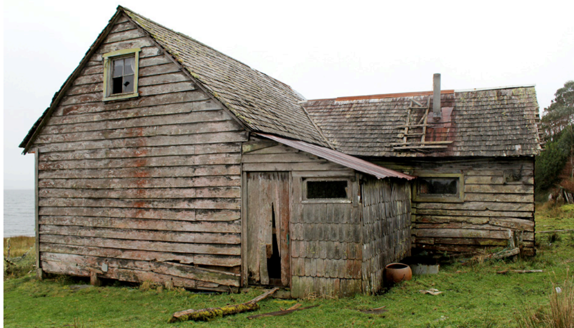
Figura 2. Uso de tejuela en techo y tingle de la ampliación. El resto de los muros han sido revestidos con tablones aserrados. Región de Aysén, sector Repollal medio (Fotografía, Castillo, C. 2013). Use of wood shingle on the roof and outer wall of the addition. The rest of the walls have been covered with sawn wood planks. Aysén region, Repollal medio area (Photograph: Castillo, C. 2013).
