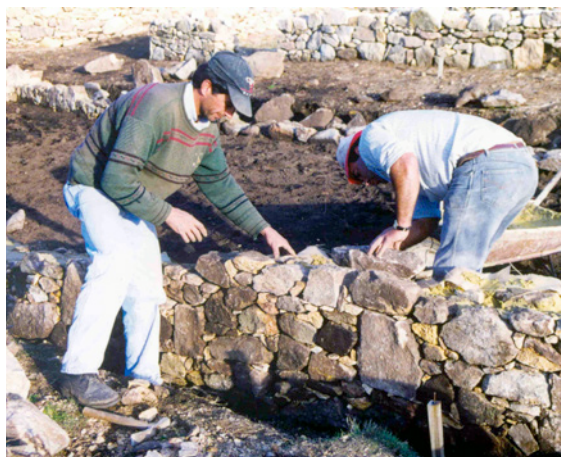
Figura 7. Trabajos de reconstitución de muros en una de las estructuras de Cossourado (Fotografía: Silva, M. de F. M. da 2013).
