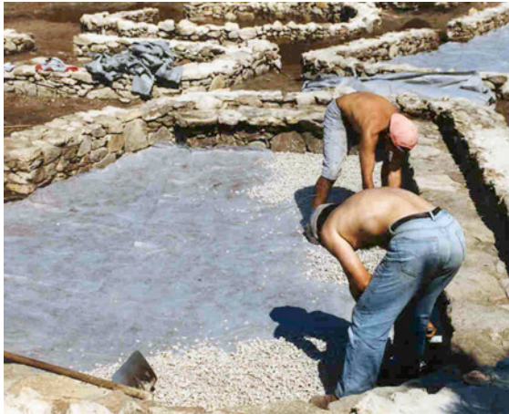
Figura 5. Construcción del sistema de drenaje en el poblado fortificado de Cossourado, municipio Paredes de Coura. Se utilizó geotextil, grava y sedimentos salidos de la excavación arqueológica (Fotografía: Silva, M. de F. M. da 2013). Construction of the drainage system on the hill fort of Cossourado, Paredes de Coura municipality. Geotextile, gravel and sediment from the archaeological dig were used (Photograph: Silva, M. de F. M. da 2013).
