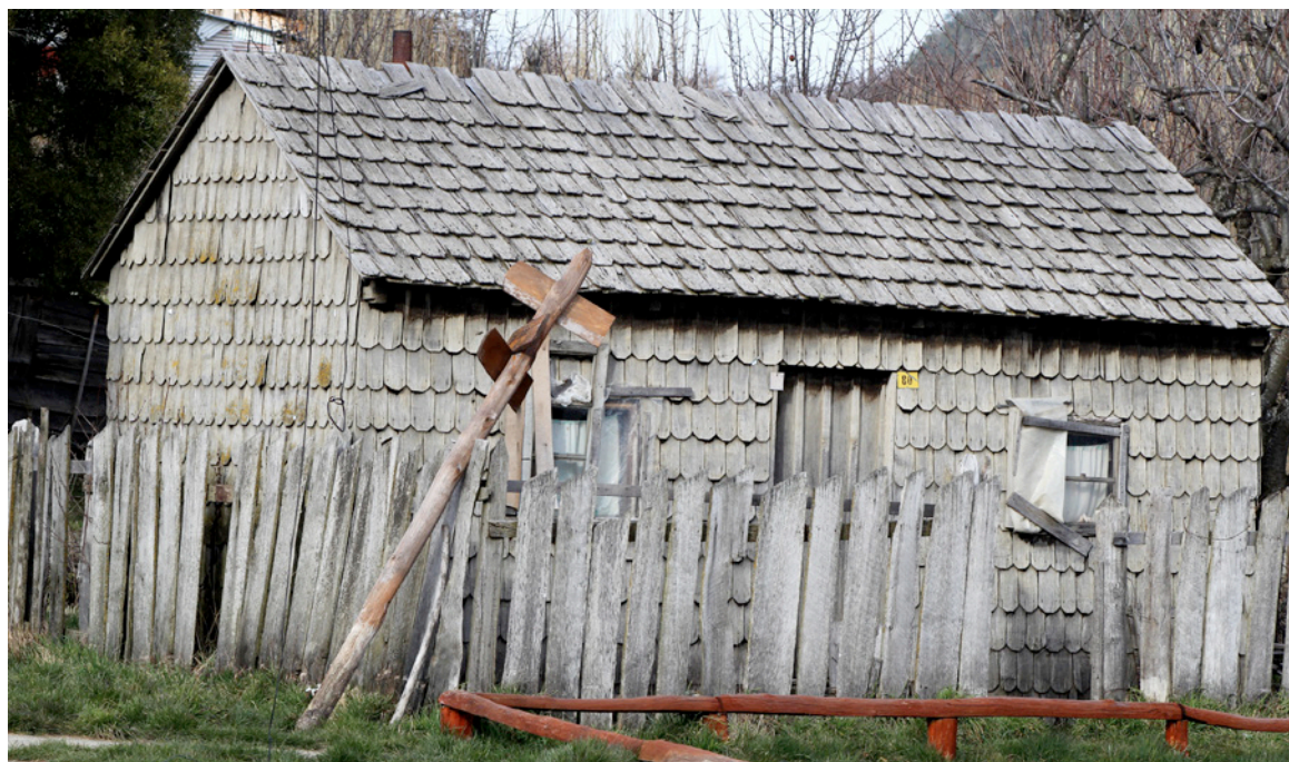
Figura 1. Construcción habitacional en la localidad de Puerto Guadal, con tejuela en techo y tingle (pared), región de Aysén (Fotografía: Castillo, C. 2013). Dwelling house in the village of Puerto Guadal, with wood shingle on the roof and outer walls, Aysén region (Photograph: Castillo, C. 2013).
