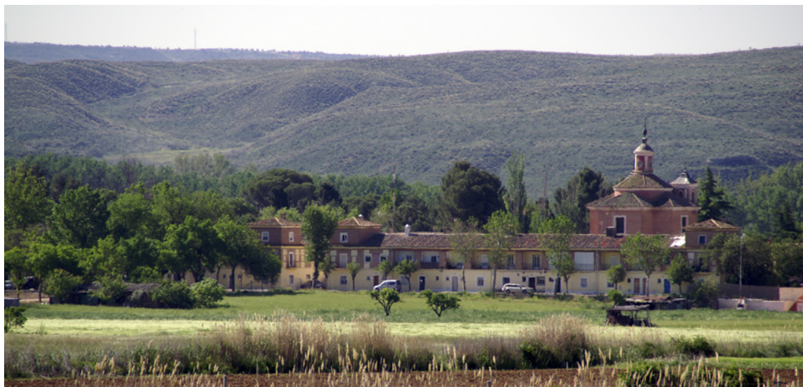
Figura 4. Real Cortijo de San Isidro. Colonia rural del siglo XVIII (Fotografía: Merlos, M. 2010). Real Cortijo de San Isidro. XVIII Century rural establishment (Photograph: Merlos, M. 2010).
