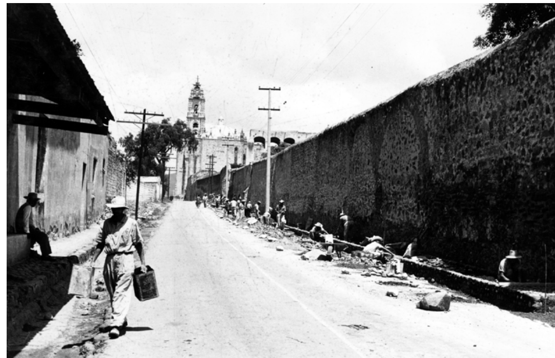
Fig. 12. Fotografía. Trabajos banquetta y barda perimetral. Coordinación Nacional de Monumentos Históricos (I.N.A.H.)
