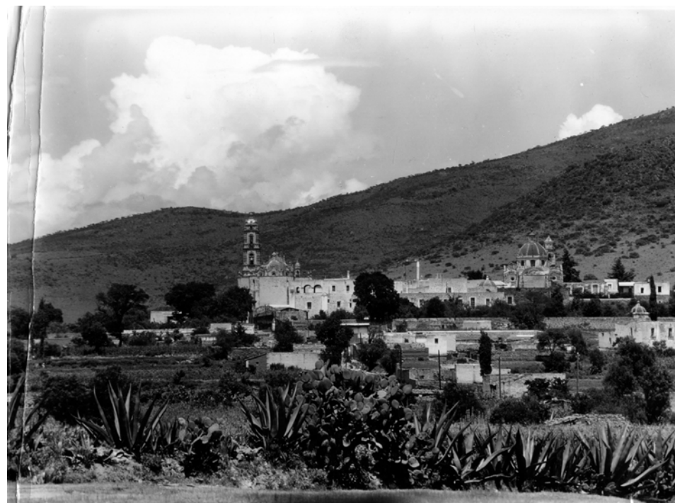
Fig. 5. Fotografía. Vista del conjunto del ex colegio jesuita de Tepotzotlán. Coordinación Nacional de Monumentos Históricos (I.N.A.H.)
