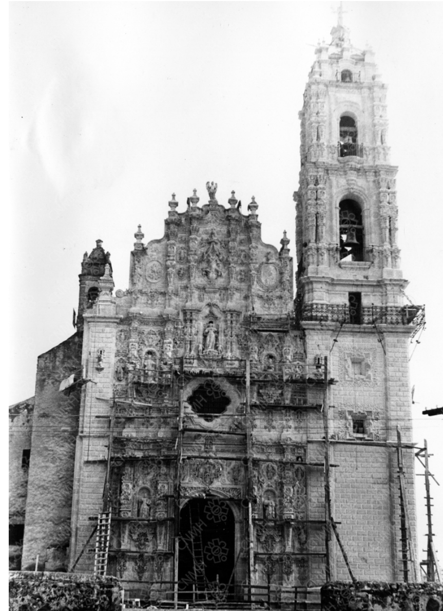
Fig. 13. Fotografía. Trabajos en la fachada del templo de San Francisco Javier. Coordinación Nacional de Monumentos Históricos (I.N.A.H.)
