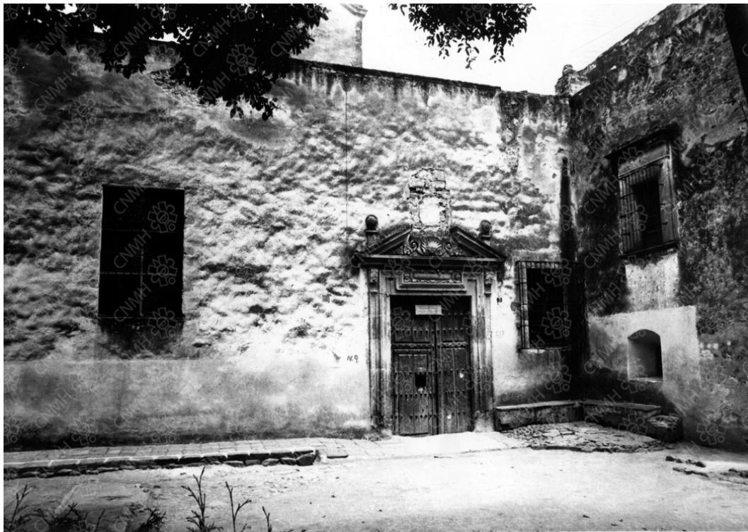
Fig. 30. Fotografía. Portería ex colegio. Coordinación Nacional de Monumentos Históricos (I.N.A.H.).
