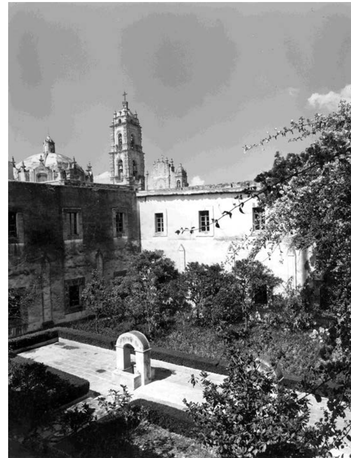
Fig. 29. Fotografía. Claustro de los Aljibes (Fototeca M.N.V.) (I.N.A.H.)
