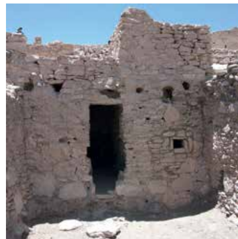
Detalle casa de dos pisos, Pucará de Lasana. (Francisco Garrido, 2008).
