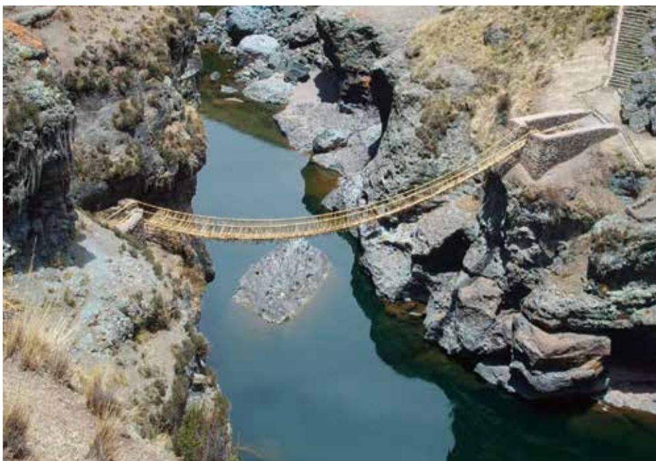
Puente de Q'eswachaka emplazado sobre el río Apurímac, Perú. (Archivo Ministerio de Cultura, Perú. c.2010).
