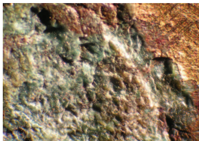
Fig. 24 Depósitos de nantoquita que, al mezclarse con otros productos de corrosión, obtienen diversas coloraciones.
