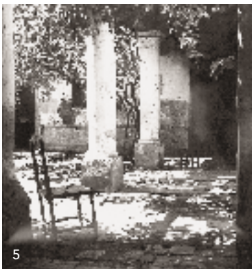
1/2. Estancias La Viña y San Miguel de Tejada, Salta. 3. Casa en Trancas, Tucumán. 4. Casa en Andalgalá, Catamarca. 5. Patio del Cabildo, San Salvador de Jujuy. 6. Plano de San Miguel de Tucumán (1814) de Felipe Bertrés, conservado en la Biblioteca de Río de Janeiro. (Fotos: 1 a 6: CEDODAL / 1, 2 y 4: Ramón Gutiérrez / 3: Federico Ortiz / 5: Hans Mann / 6: Biblioteca Nacional de Río de Janeiro).
