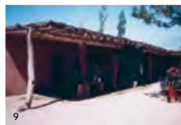
6. Bóvedas de Uspallata, Mendoza. 7. Casa de galería en Anjullón, La Rioja. 8. Casa de galería en El Trapiche, Godoy Cruz, Mendoza. 9. Rancho en Chuquis, La Rioja. (Fotos: 1 a 3: AGN // 4 y 5: Sergio López Martínez // 6 y 8: CEDODAL // 7: Graciela Viñuales / CEDODAL // 9: Archivo Macchi / CEDODAL).
