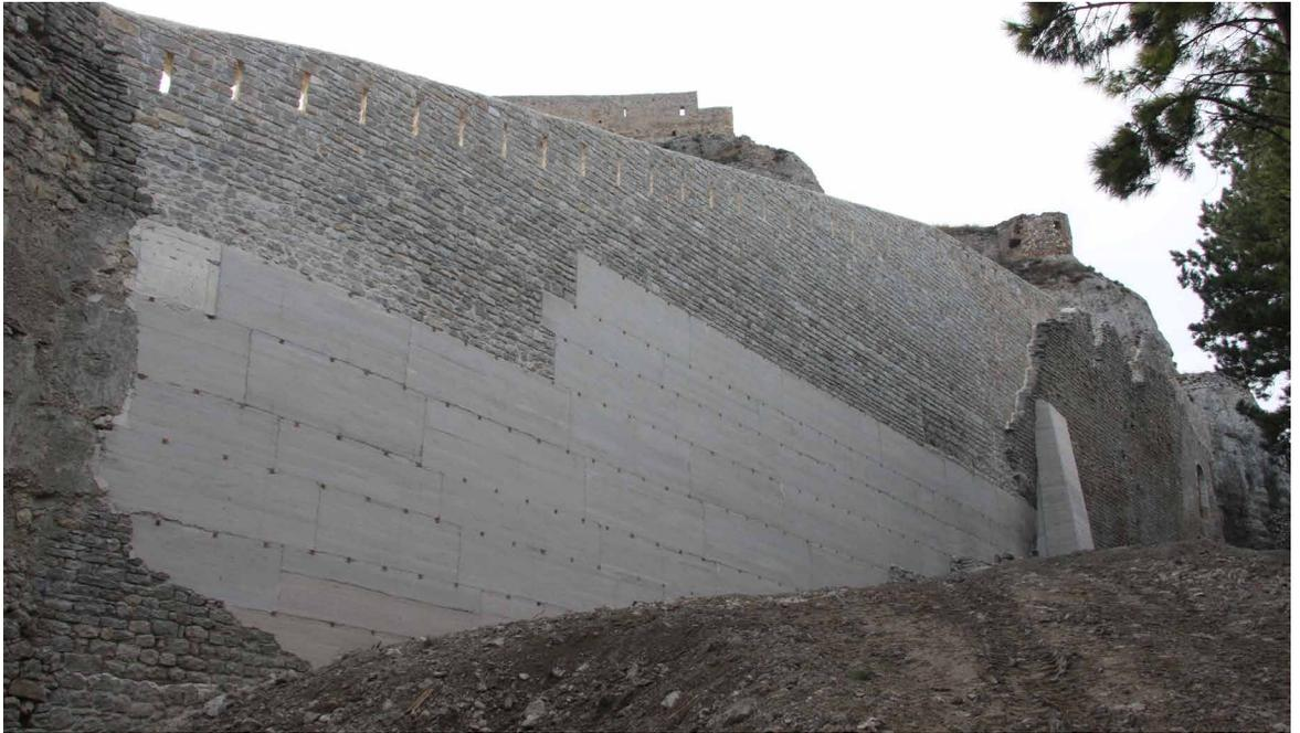
Fig. 8. Resultado de la intervención, imagen desde el exterior con el posicionamiento del contrafuerte en la zona más desplomada del lienzo estabilizado. Fotografía: Luis Almena Gil.
