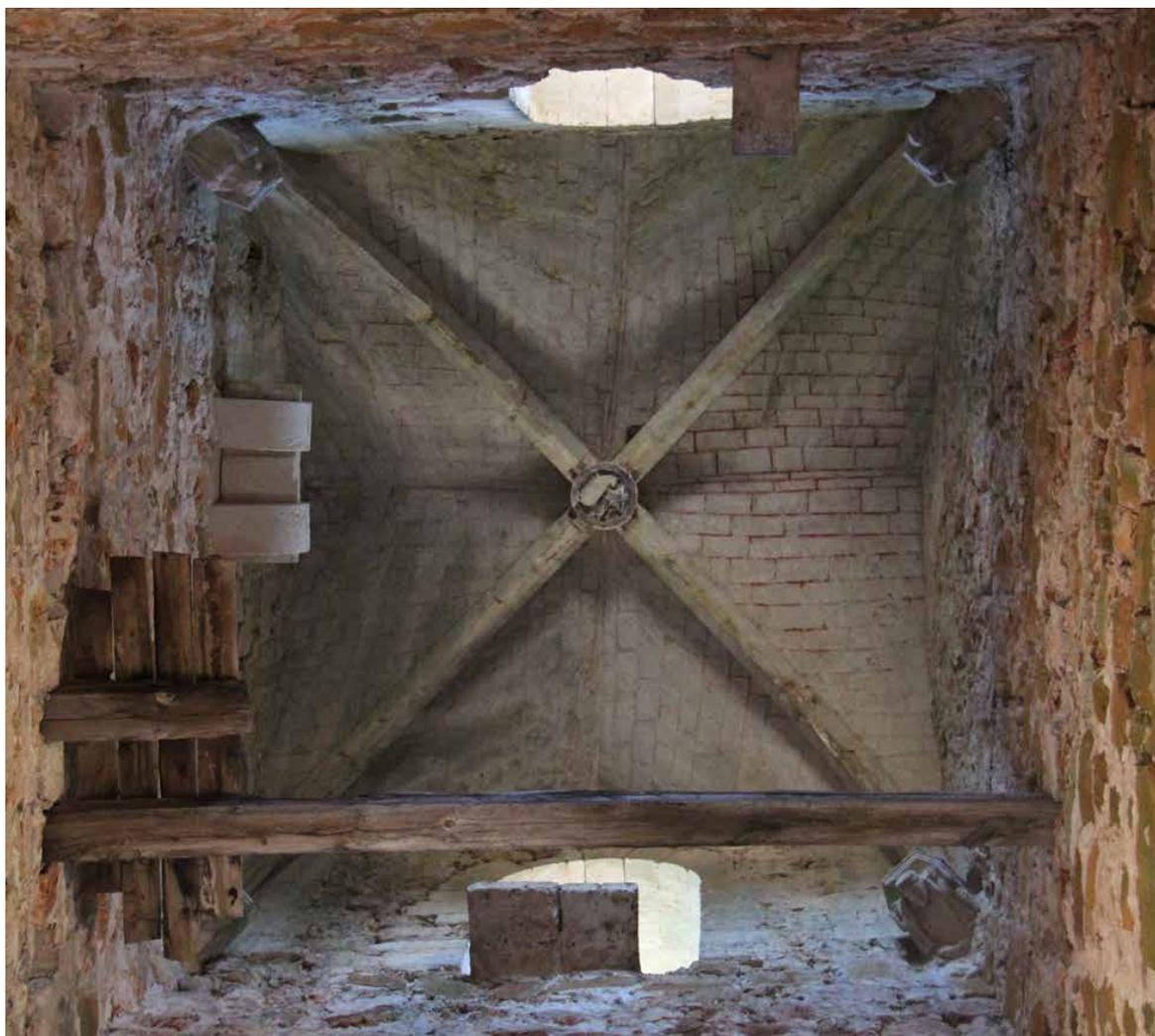
Bóveda del interior de la torre con revestimiento de sillería fingida.
