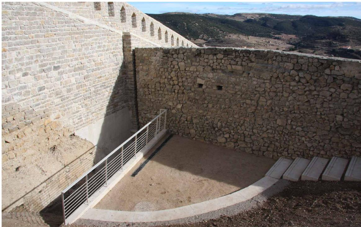
Fig. 10. Resultado por el interior tras el rebaje de los rellenos que generaban empujes a la muralla.
