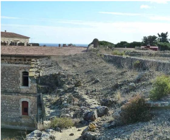
Restos de los muretes que encajonaban las tierras de una cubierta a prueba, revestida de solera de ladrillo o de tejas en un edificio de viviendas de la Fortaleza de San Fernando de Figueras (2013).
