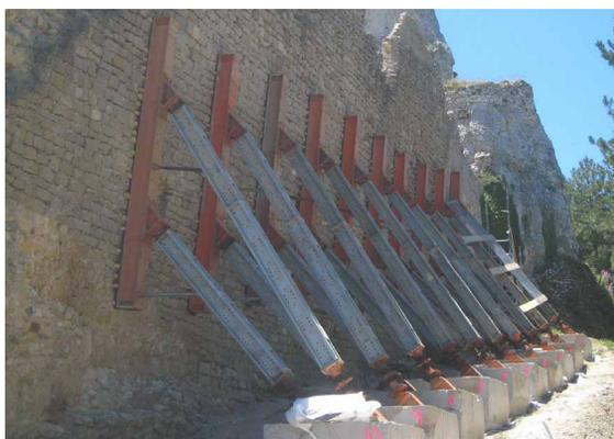
Fig. 5. Apeo provisional del tramo entre la zona del primer derrumbe y la Puerta Ferrisa. Fotografía: Luis Almena Gil.
