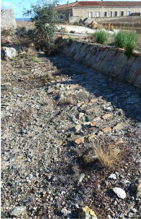
Únicos restos conocidos de la capa de teja que se tenía que colocar bajo el relleno de tierras. Están visibles en el extremo Oeste del edificio de viviendas Sur de la Plaza de Armas cuya cubierta quedó a medio desmontar en las remodelaciones realizadas entre 1941 y 1945. Figueras [2013].
