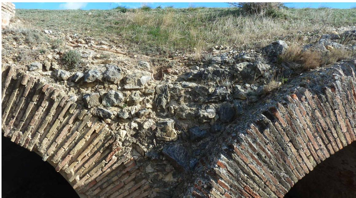
Bajo las tierras y encima de la mampostería, se pueden apreciar los planos inclinados de ladrillo que conducían las aguas de infiltración a las canales. San Fernando de Figueras (2013). Fotografía: Rafael Vila.
