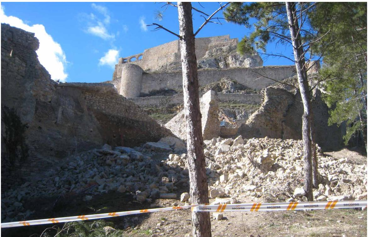
Fig. 2. Estado del tramo de muralla tras el segundo derrumbe en marzo de 2013. Fotografía: Luis Almena Gil.
