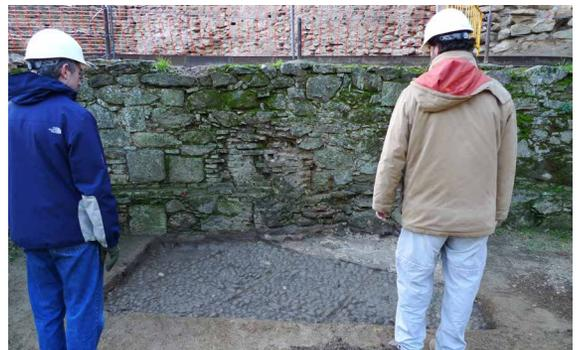
Vista del muro del coso con elementos arquitectónicos embebidos a tizón y del pavimento original a base de encintados de ladrillo formando cuadrados y el interior de canto rodado, tomado con mortero de cal. Fotografía: Pedro Ponce de León.
