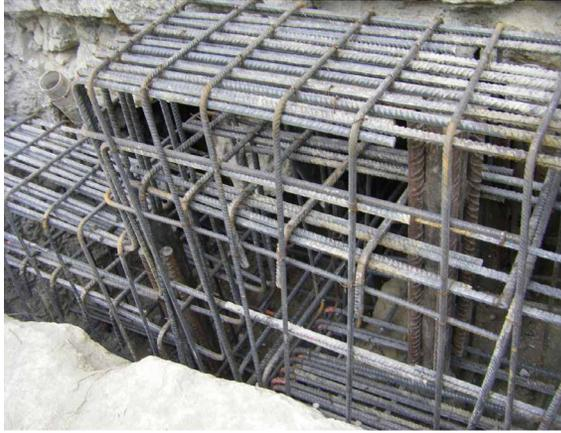
Fig. 6. Armado de la viga de atado de los micropilotes de recalce de la cimentación de la muralla. Fotografía: Luis Almena Gil.
