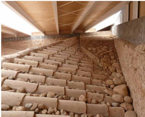
Reproducción del sistema de capas de drenaje de las cubiertas de la Puerta Avanzada, que combina una degradación de rellenos de gredas de arriba abajo con bolos decrecientes en tamaño y proporción hasta llegar a desaparecer de abajo a arriba. Figueras (2011). Fotografía: Rafael Vila.
