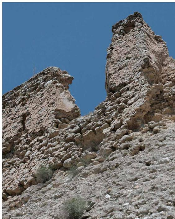
Fig 6. Degradación de las fábricas de yeso. Fallo de los apoyos sobre la roca y descomposición superficial. Fotografía: P. Iglesias.
