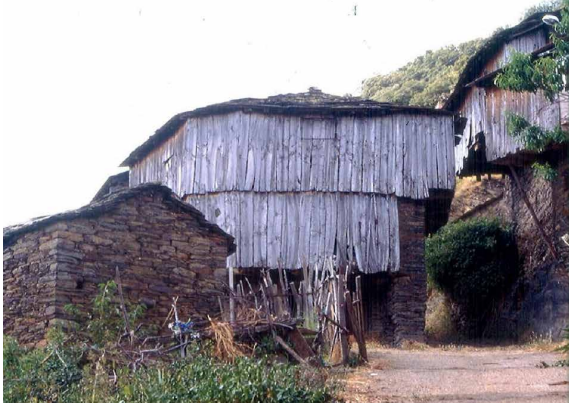
Fornia, casa del doble corredor. Fotografías: Concha casado
