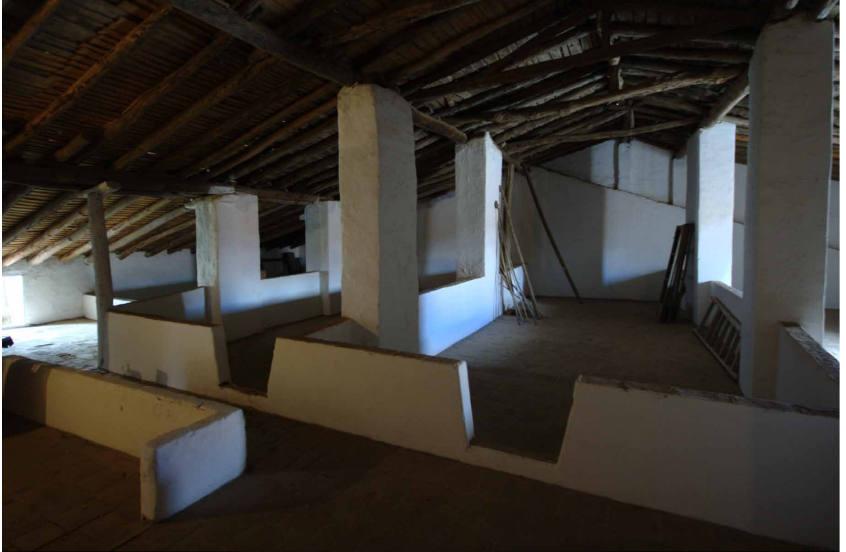
Medina de las Torres. Inventarios para dar a conocer y contribuir a valorar los contenidos de la arquitectura tradicional. Fotografía: Aniceto Delgado. Inventario de arquitectura vernácula extremeña.
