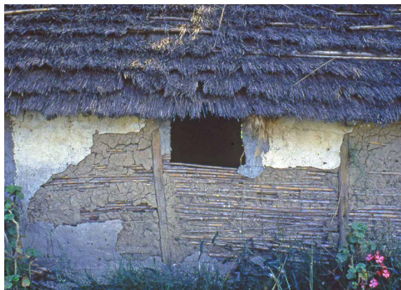
Detalle del enfocado lateral de una barraca abandonada. Fotografía: Salvador Viladrich. Archivo del MTTE.
