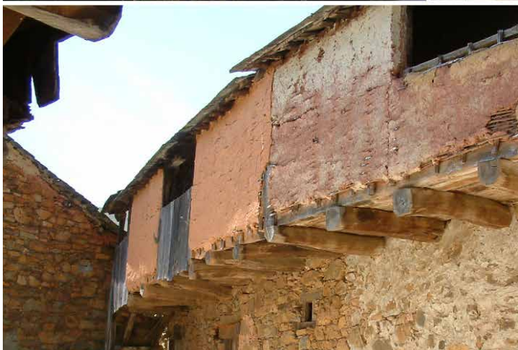
Corredor en Villar del Monte (Cabrera Alta). Manzaneda (Cabrera Alta). Corredor de entretejido vegetal enfoscado con barro, restos de encalado (Villar). Corredor semicerrado Ambasaguas (C. Baja). Fotografías: Concha Casado y Javier Sastre.
