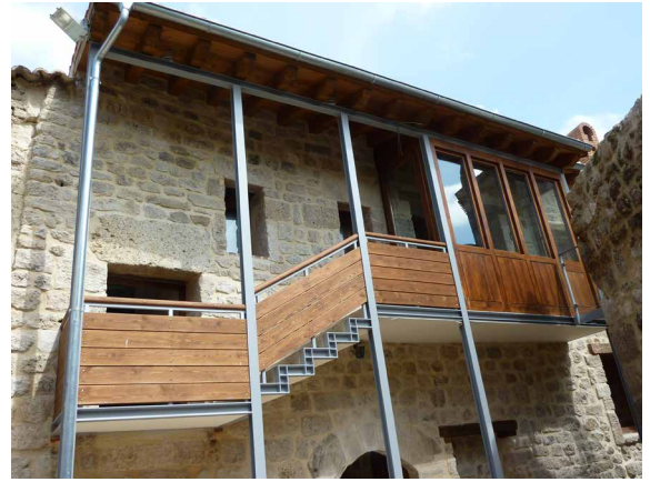
Detalle de la nueva galería-escalera hacia el patio. Fotografía del autor.
