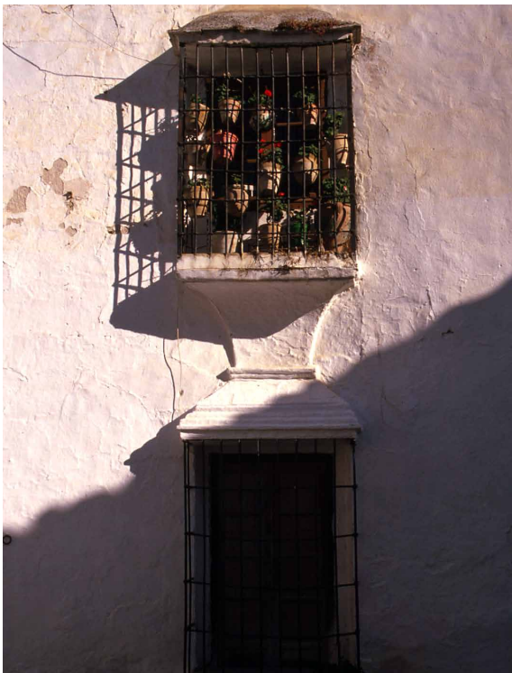
Detalle de fachada encalada en Ronda (Málaga) concebida al modo tradicional en el que la cal se aplica directamente sobre el muro, lo cual confiere al paramento una rugosidad y riqueza lumínica y de matices espléndida. Fotografía: Félix Benito.
