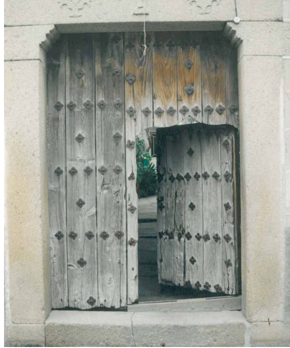
Portón de entrada a la Casapuerta. Fotografía: Eduardo de Santiago.
