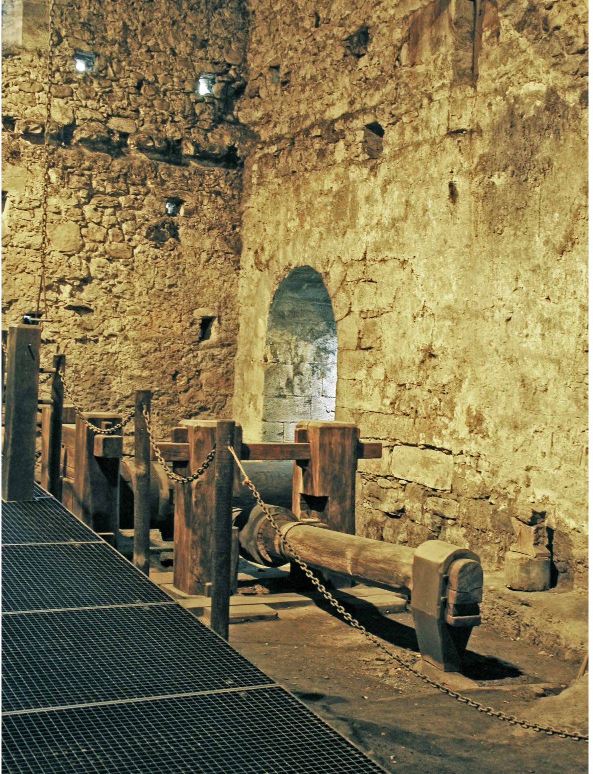
Restauración arquitectura hidráulica la ferrería de Cades. Cantabria. Fotografía: Luis Azurmendi y Angeles Gómez Carballo.
