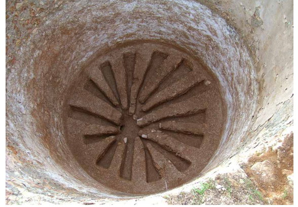
Sistema de drenaje del pozo de nieve del Cristo de Villajos (Campo de Criptana, Ciudad Real). Fotografía: Miguel Ángel Hervás.
