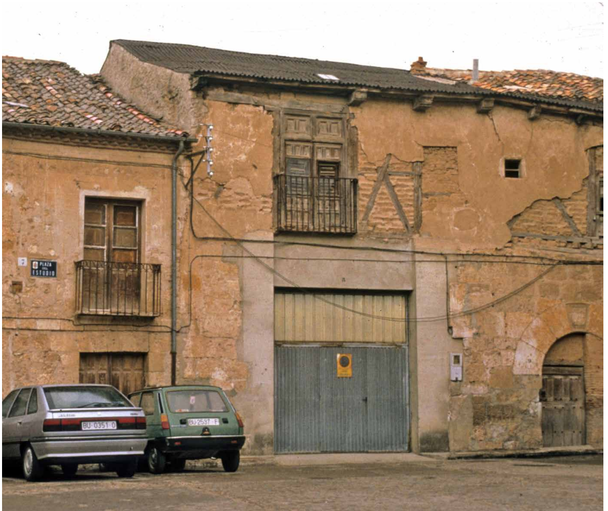
En esta casa particular de Cabrera Alta (León), de valiosa arquitectura bajomedieval se ha abierto una gran puerta de garaje que la ha mutilado. Fotografía: Félix Benito.
