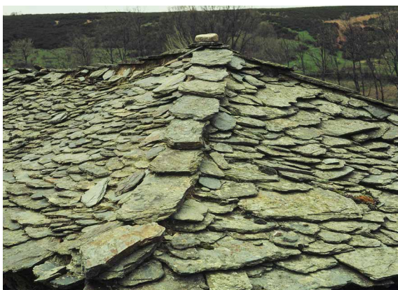
Detalle de cubierta de pizarra en El Espinar. Fotografía: Luis Maldonado.
