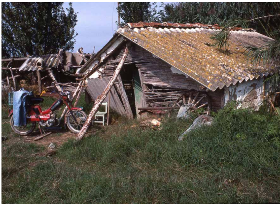
Antigua barraca, hoy desaparecida, reparada con tejas y Uralita. Fotografía: Salvador Viladrich. Archivo del MTTE.
