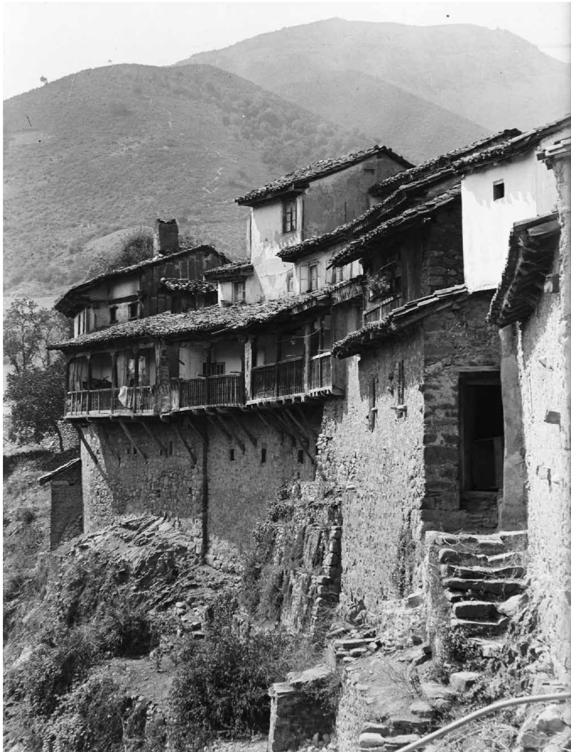
Potes. Casas en el río. Fotografía: Fototeca del Patrimonio Histórico. Instituto del Patrimonio Cultural de España. Otto Wunderlich.
