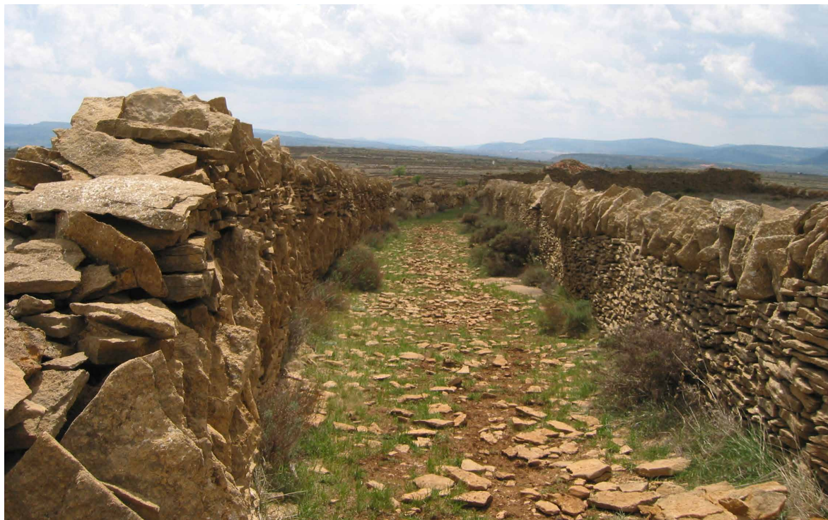
Azagador. Construcción en piedra seca, Iglesuela del Cid. Fotografía: Mercedes Souto.
