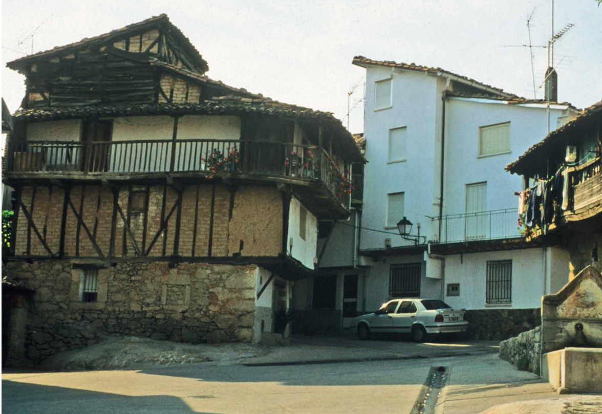
Edificio de cuatro alturas con entramado de madera y adobe en las superiores, en parte visto, y en parte encalado, sobre un muro de carga de mampostería y sillería de granito. Al fondo, un edificio moderno de semejante volumen y distribución de huecos con distintos materiales. A la vista queda la integración cuando sólo las formas y líneas globales se armonizan, pero no el color y la textura. Villanueva de la Vera (Cáceres). Fotografía: Félix Benito.
