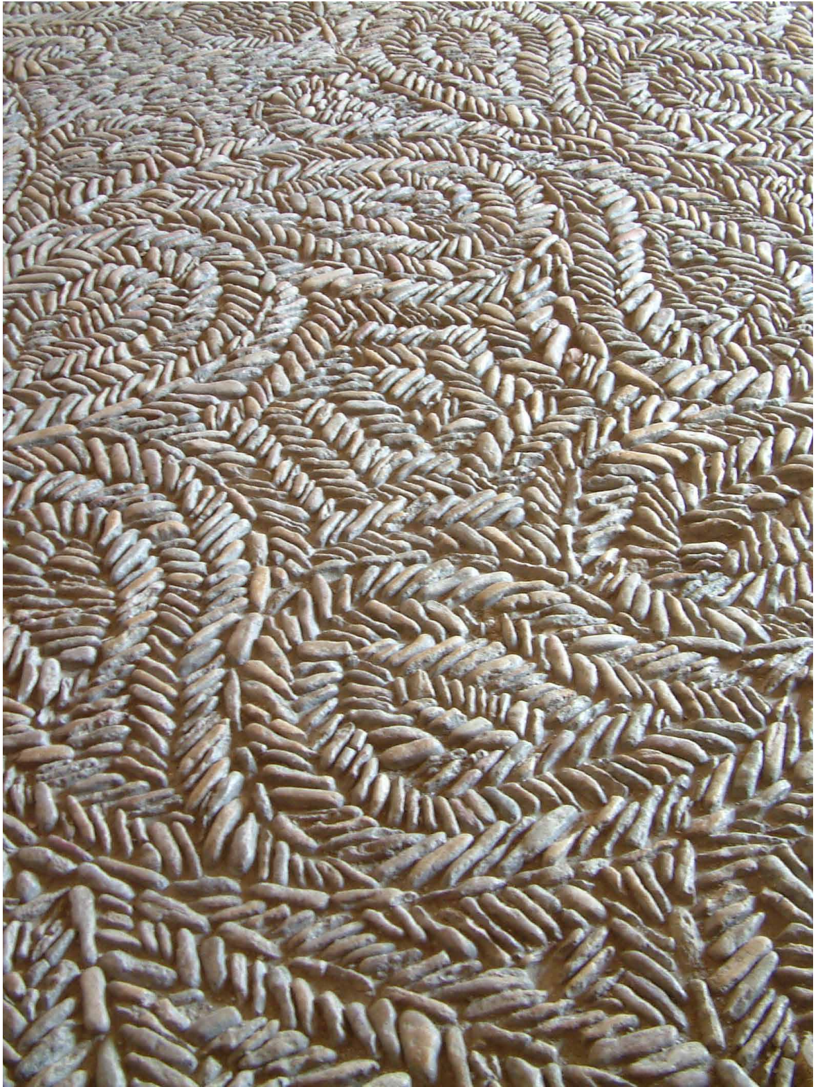
Pavimento dibujado de gujarros de río restaurado. Fotografía: Vegas & Mileto.
