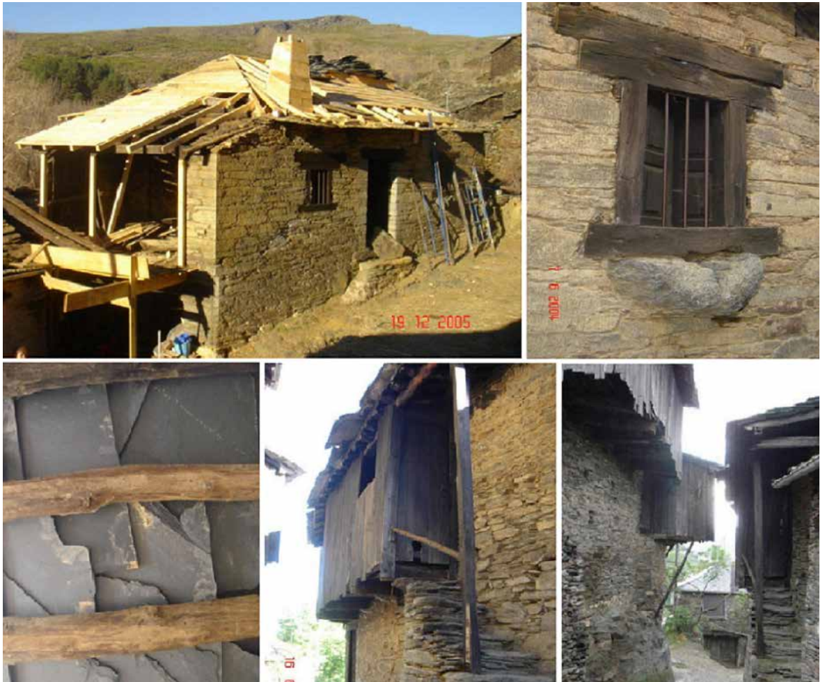
Recuperación del antiguo barrio de forna. Losas toscas en cubierta según el estilo tradicional. "Coladeira" de desagüe. Corredores.
