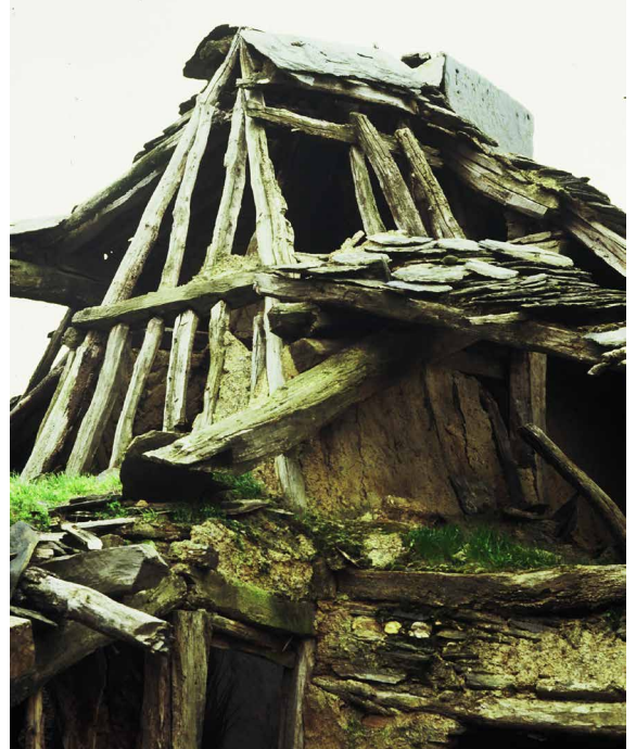
Detalle de estructura de chimenea en Majaelrayo. Fotografía: Luis Maldonado.
