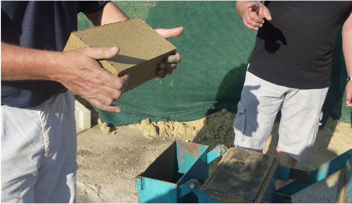
Fabricación de bloques de tierra comprimida. Taller formativo Eco-Arq de Castrojeriz. Fotografía del autor.
