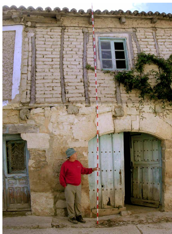
Fachada de la calle Real 15, estado original. Fotografía del autor.
