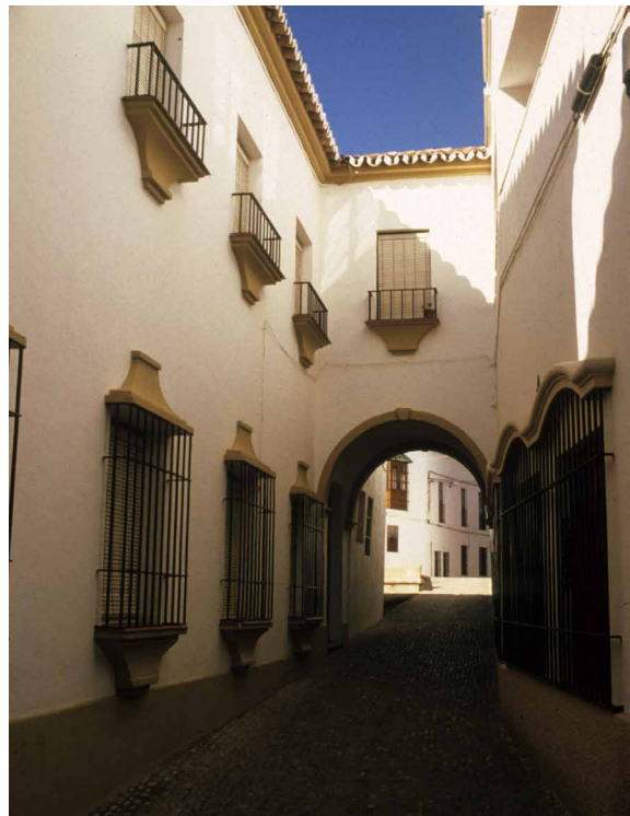
En este conjunto de edificios también en Ronda (Málaga) vemos como la cal aplicada sobre muros maestreados de cemento carece de la riqueza de matices del anterior. Casi toda la ciudad de Ronda es hoy así. Fotografía: Félix Benito.
