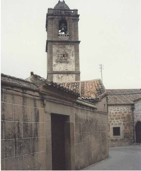
Puerta carretera de acceso al patio desde el exterior (sin Casapuerta). Fotografía: Eduardo de Santiago.
