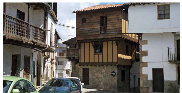
El mismo edificio reconstruido intentando imitar las soluciones primitivas con este resultado. En parte, por el aumento de volumen debido a una normativa que no ha comprendido la arquitectura tradicional. Fotografía: Félix Benito.
