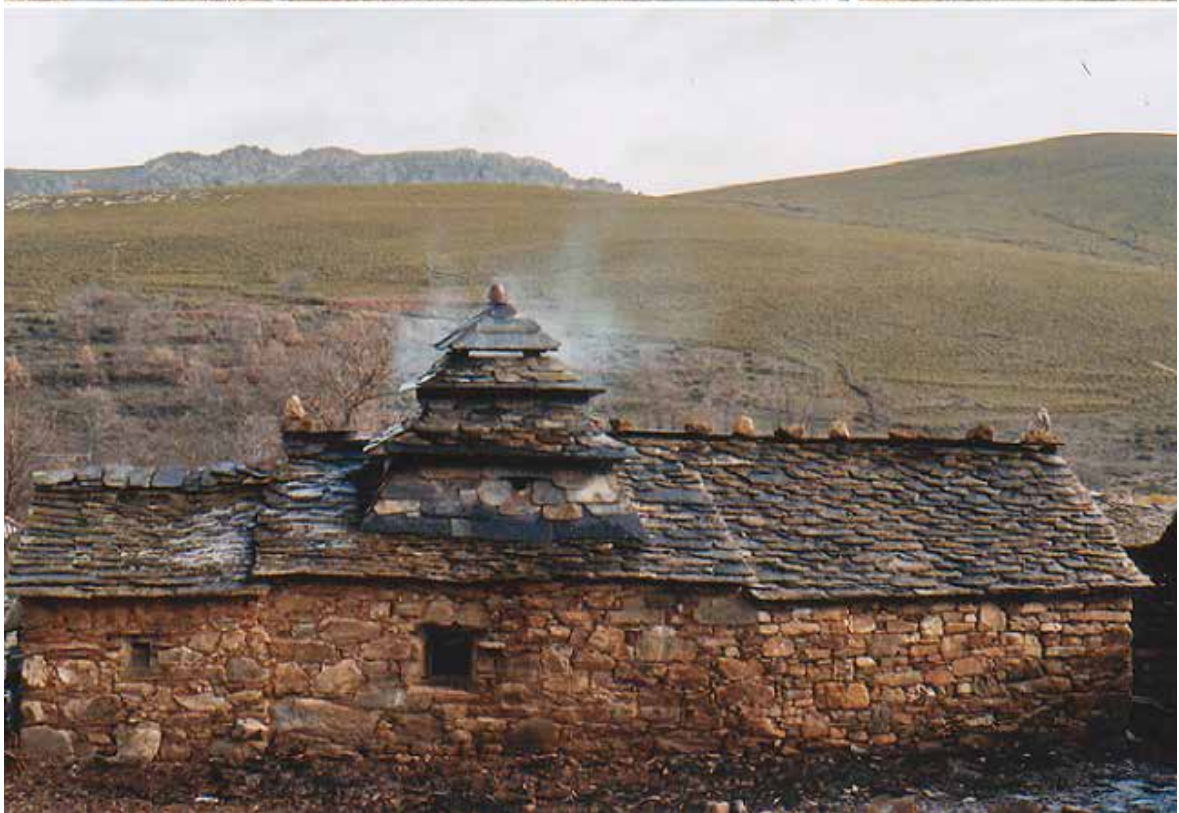
Recuperación de la casa de la Chimenea. Villar del Monte. Fotografías: Concha Casado y Javier López-Sastre.
