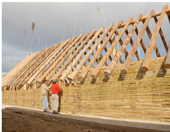
Encañizado de la barraca del Centre d'Interpretació de les barraques del delta del Ebre, el 2010. Fotografia: Jordi Homs. Archivo del MTTE.
