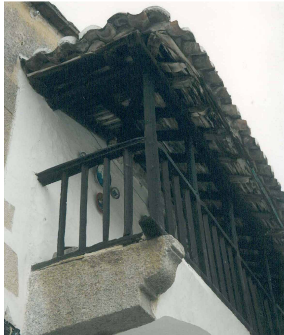
Detalle de la construcción de la balconada. Fotografía: Eduardo de Santiago.
