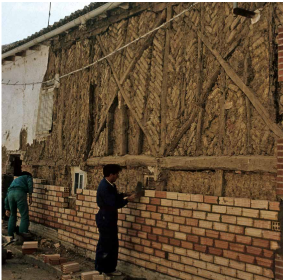
Obra que se está realizando en el momento de la fotografía, tapando un acabado de entramado con barro mediante ladrillo hueco para enfoscar. Fotografía: Félix Benito.
