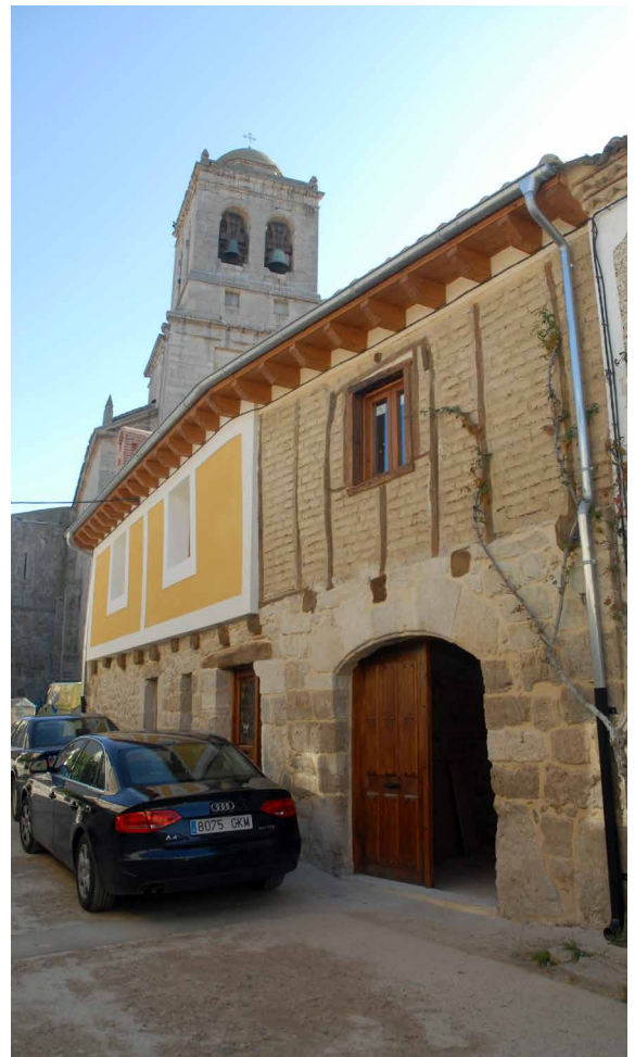
Fachadas de la calle Real 13 y 15, estado final. Fotografía del autor.
