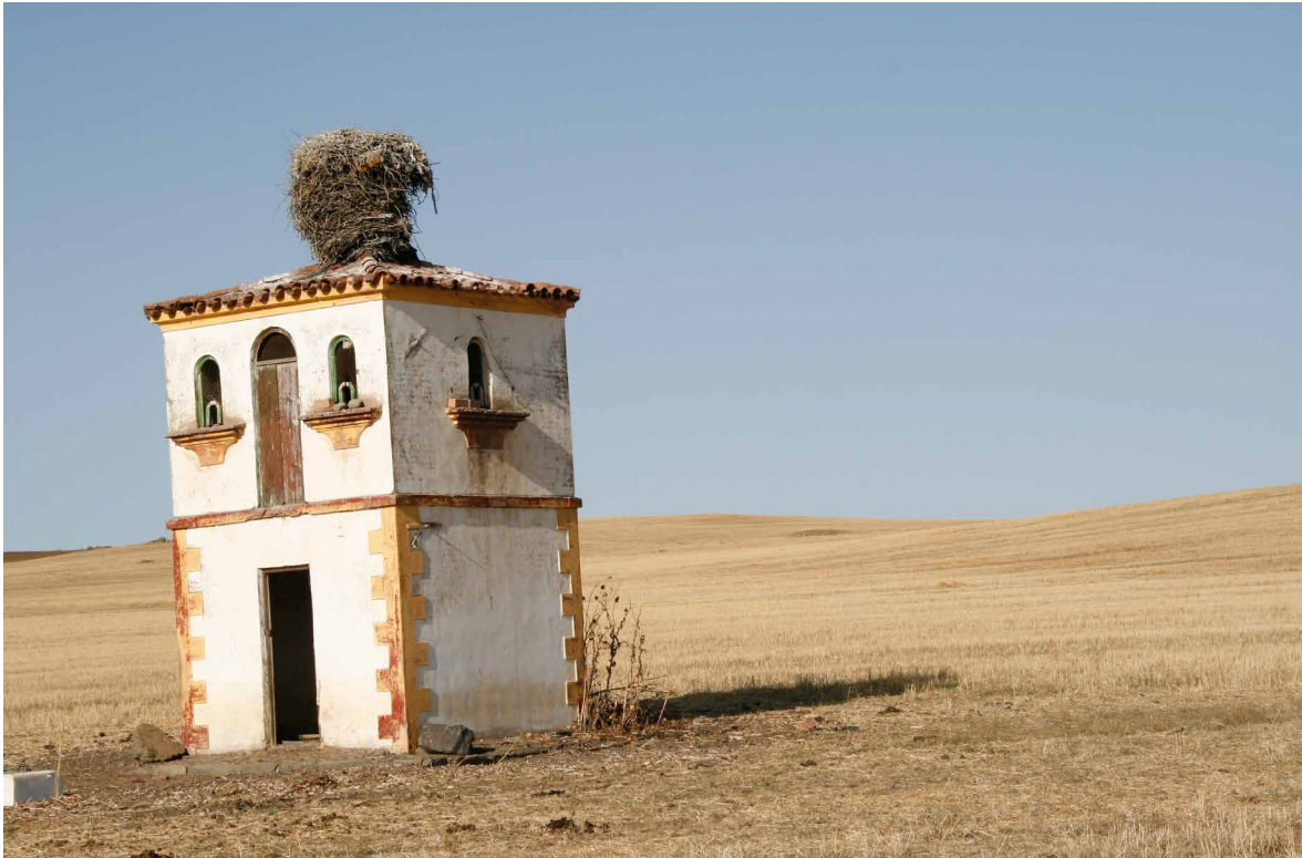
Valencia del Ventoso. Derroches estéticos en una arquitectura funcional. Fotografía: Aniceto Delgado. Inventario de arquitectura vernácula extremeña.
