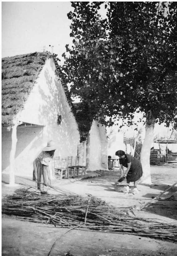
Barraca con solibert y puntal acabado en horquilla, cap forcat , años 1950. Autor desconocido. Archivo del MTTE.
