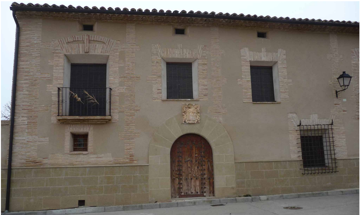
Ponzano. Casa del Somontano, después de la rehabilitación. Ejemplo de Buenas Prácticas. Fotografía: Ignacio Pardinilla. Archivo de la Comarca de Somontano de Barbastro.
