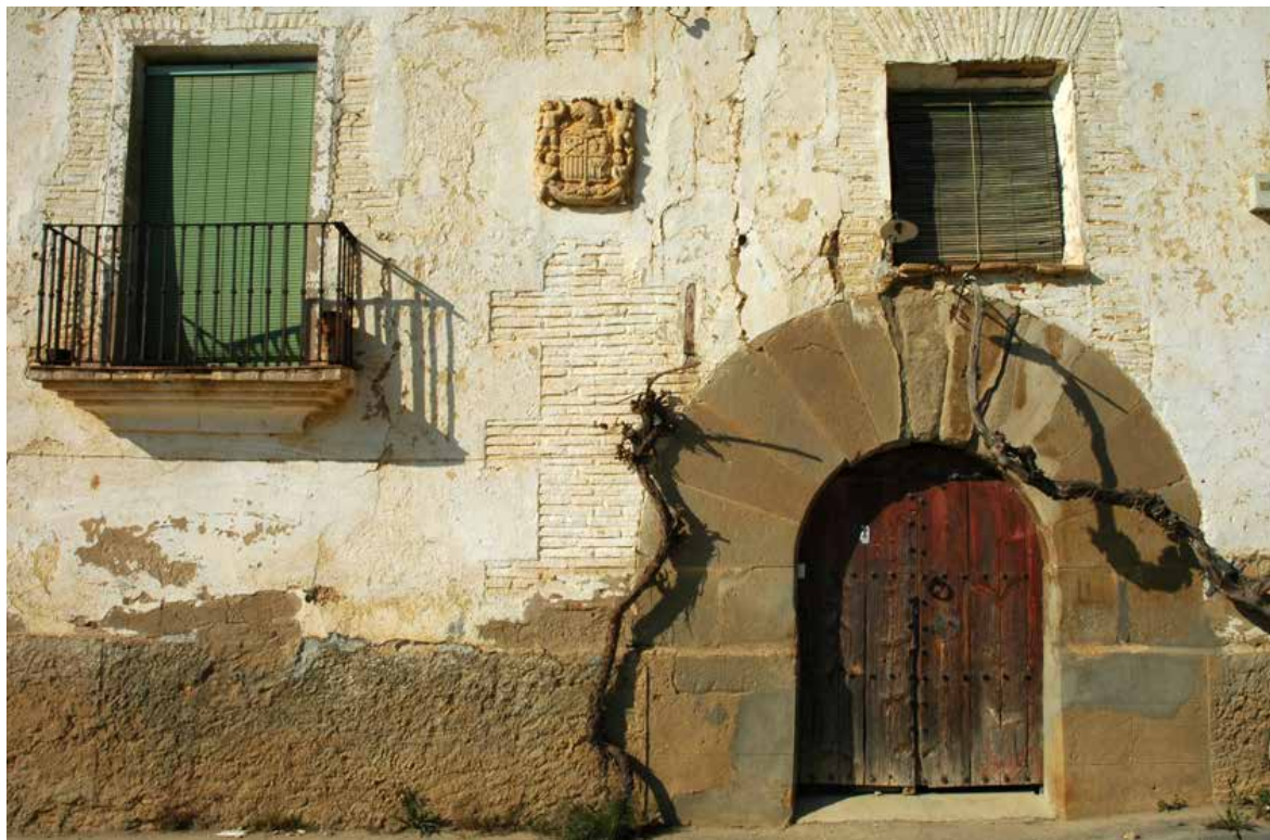
Casa de Lacellas. Ejemplo de fachada característica de la casa del Somontano. Fotografía: Ignacio Pardinilla. Archivo de la Comarca de Somontano de Barbastro.
