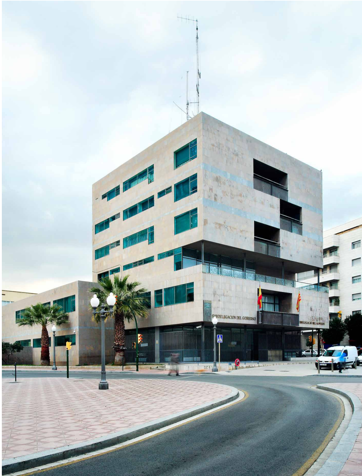
Alejandro de la Sota, Gobierno Civil de Tarragona. Intervención a cargo de Alejandro de la Sota y Josep Llinás. Fotografía: © José Hevia.
