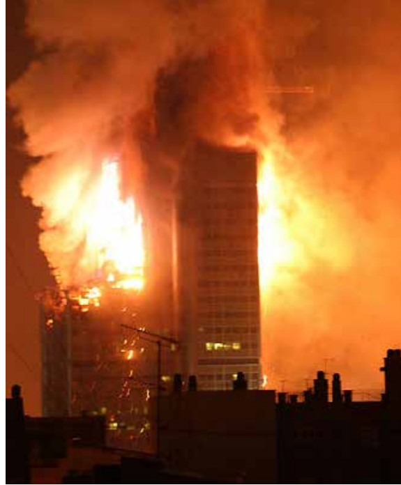
Imagen 60. Incendio del Edificio Windsor la noche del sábado 12 de febrero de 2005.
