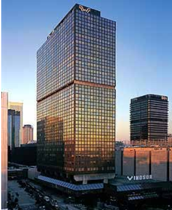
Imagen 59. Alas / Casariego y Del Rio / Ferrero. Edificio Windsor. Madrid. 1974-1979.
