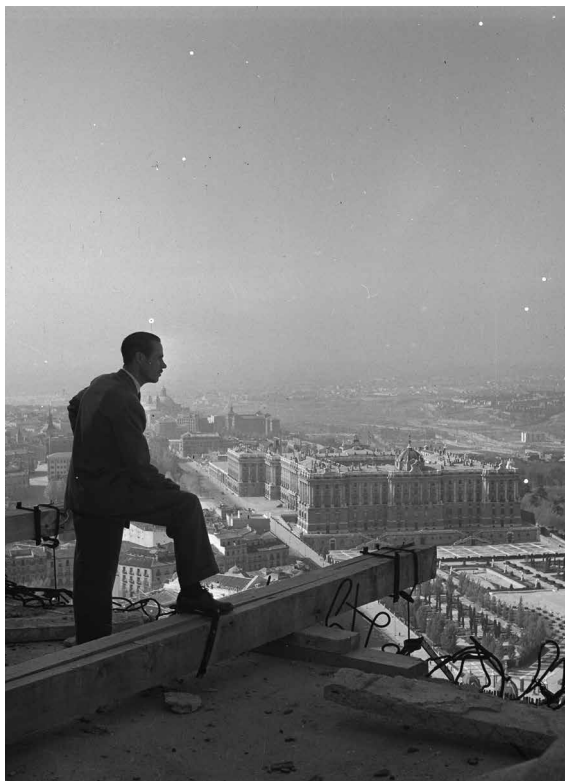
Figura 3: Juan Pando: Edificio España en construcción, en la foto, ¿Carlos Mendoza?, 1952. Julián Otamendi y José M. a Otamendi. Ministerio de Educación, Cultura y Deporte. Instituto del Patrimonio Cultural de España.
