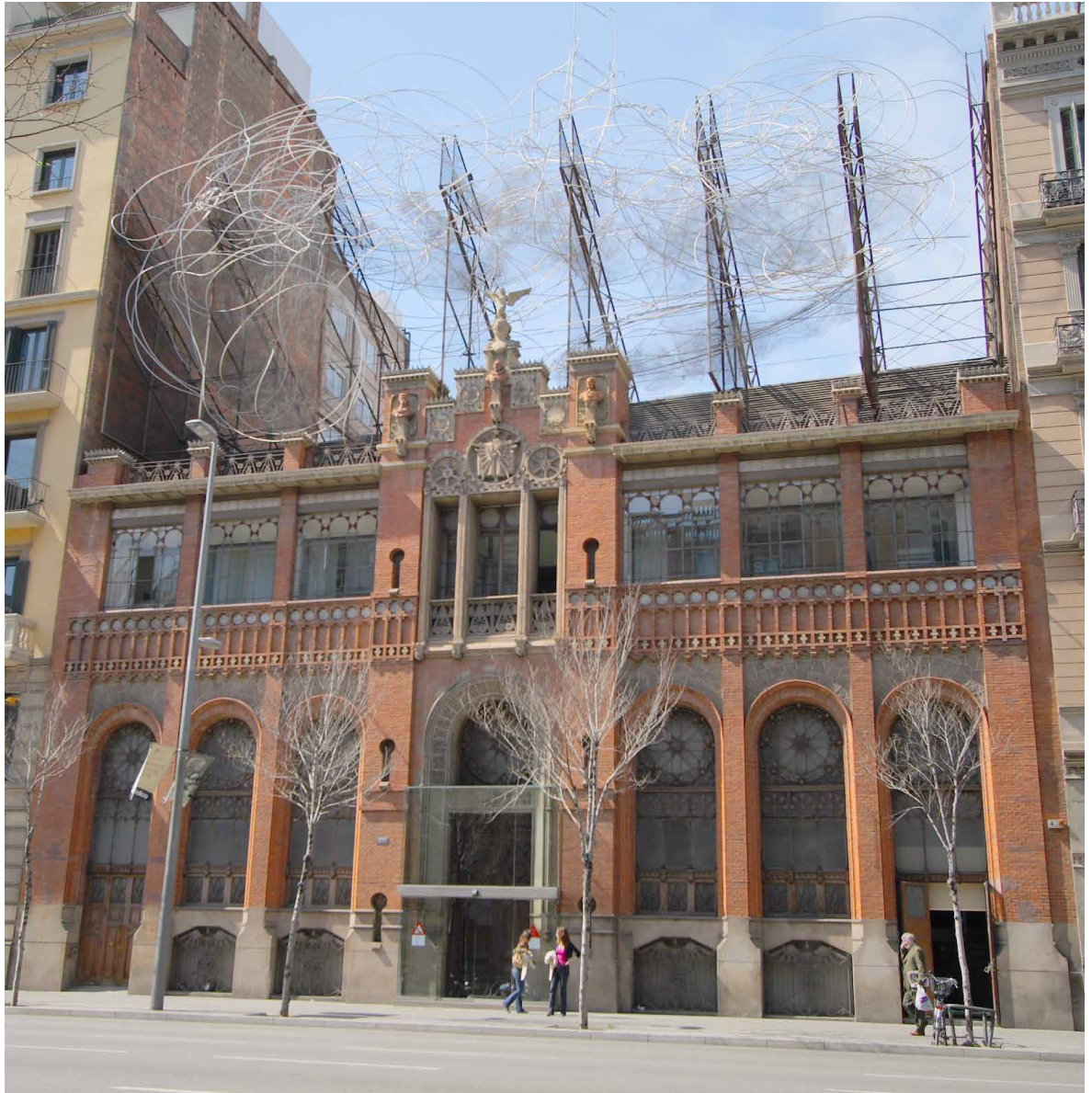
Imagen 2. Lluís Domènech i Montaner, edificio de la editorial Montaner i Simó, Barcelona. Intervención a cargo de Óscar Tusquets y Lluís Clotet. Fotografía: Andy Cheung, con licencia Creative Commons de Flickr: https://tiny.cc/71hu3x .
