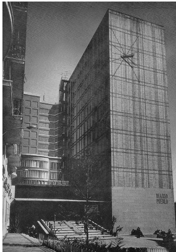
Imagen 49. Rafael Aburto. Edificio del Diario Pueblo. Madrid. 1959. Fotografía: Kindel.
