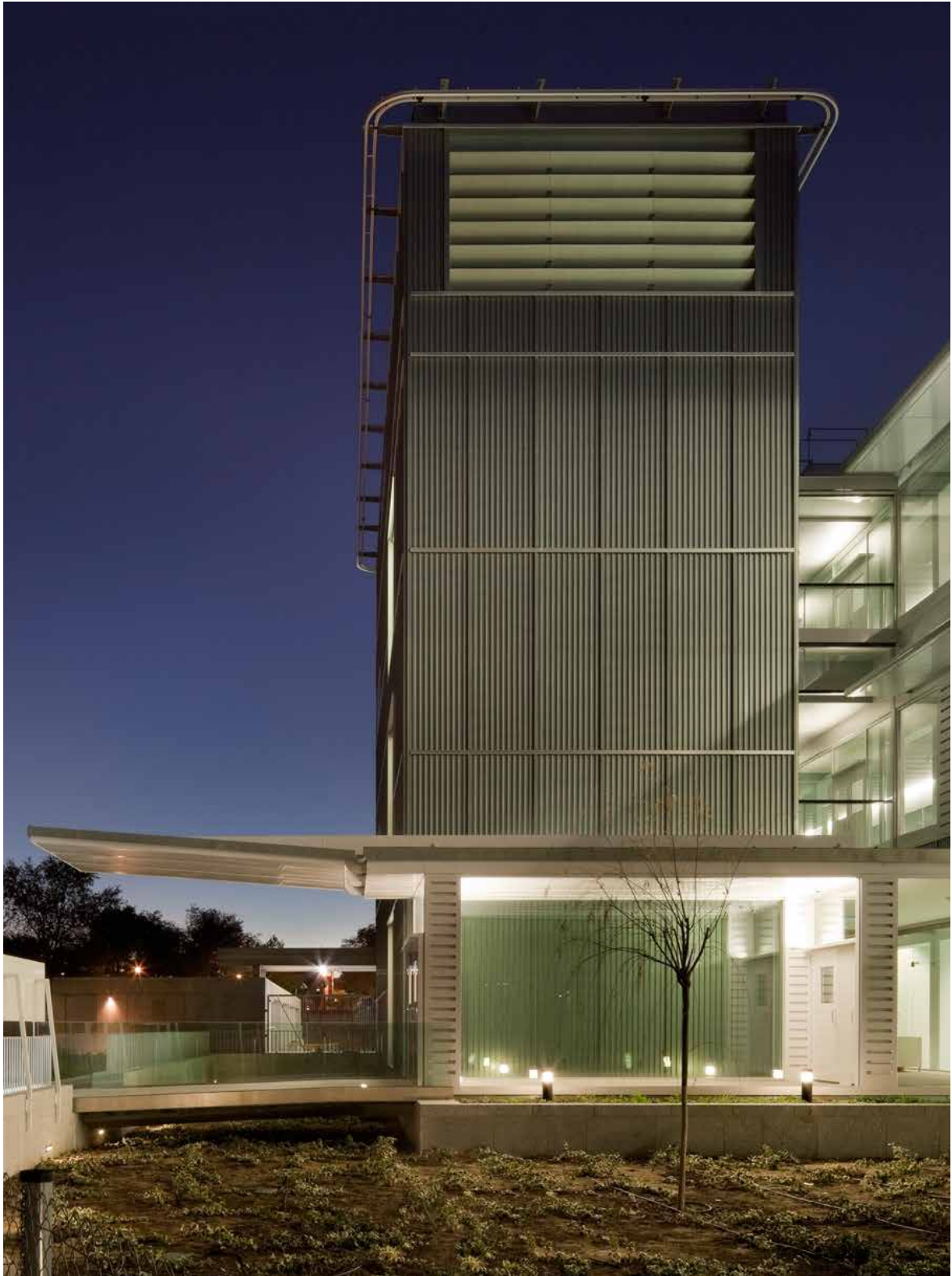
Vista nocturna del Centro de Conservación y Restauración de la Filmoteca Española.
