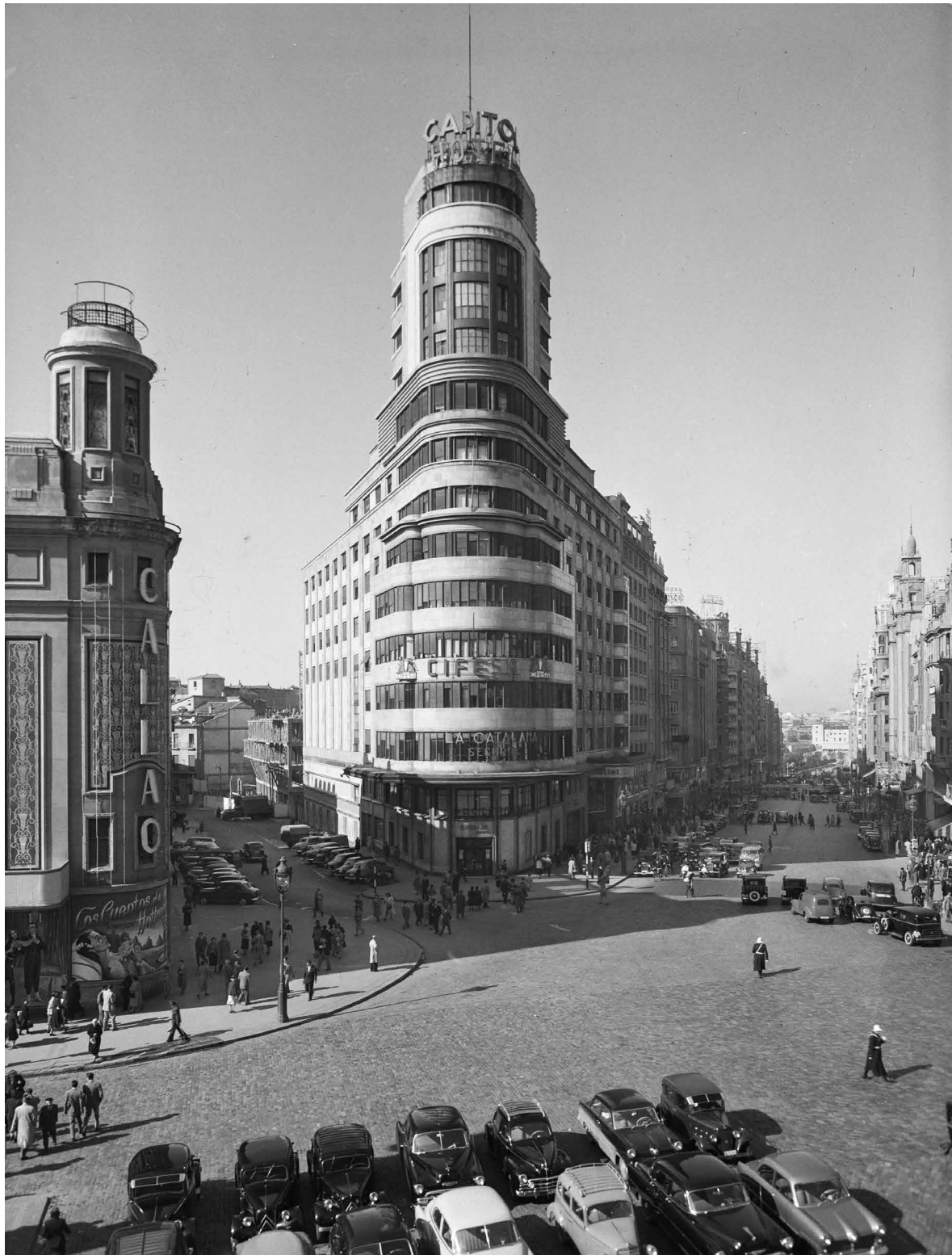
Archivo PANDO N° PAN-061227 Edificio Capitol, entre Jacometrezo y Gran Vía, Madrid. Arqto. Luis Martínez Feduchi. Fotografía: 1953 Archivo Pando IPCE.
