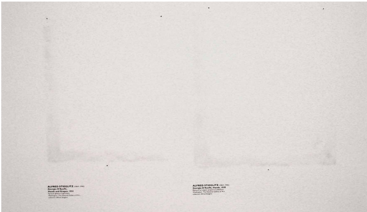
Imagen 4: Imagen de una de las paredes de las salas de un Museo donde podemos apreciar los restos de suciedad provocados por la contaminación tras tres meses de exposición. Fotografía: Juan Antonio Sáez Décano.
