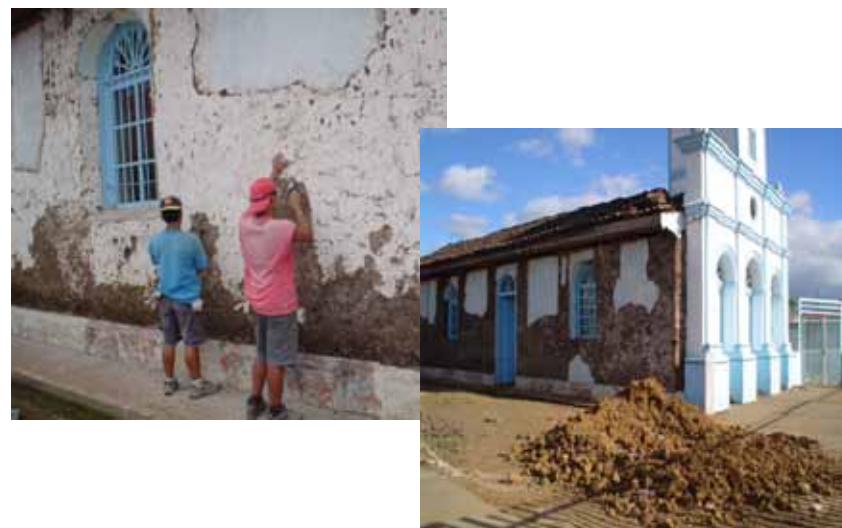
FIG 57, 58: Proceso de Restauración, Iglesia en Alajuela, Costa Rica
