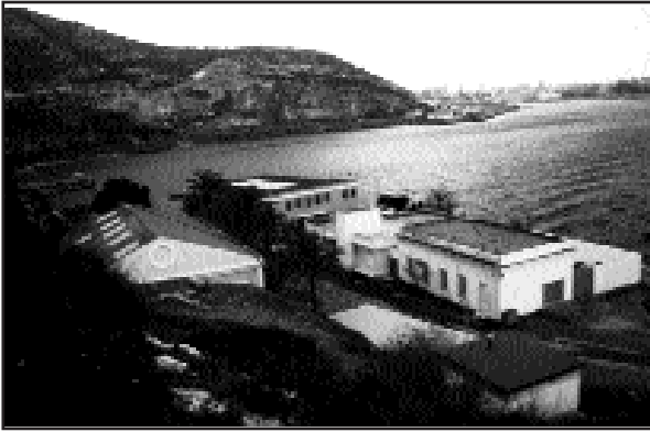
Vista general de las instalaciones del Museo Centro. En primer plano, a la izquierda, con el tejado de uralita a dos aguas, el Museo. A la derecha, tres edificios. El del fondo, de color salmón, es el Centro Nacional de investigaciones submarinas. Los otros dos, almacenes. Al fondo, Cartagena.
