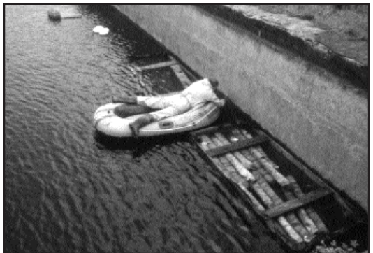
Lámina VI: Trabajos de anclaje
