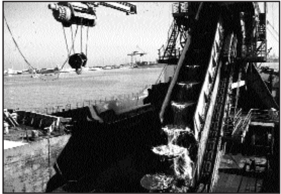
Trabajos de dragados en la Bahía de Cádiz
