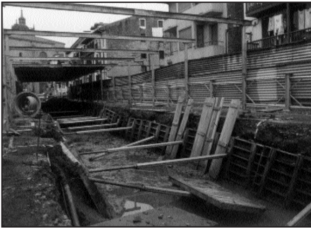
Lámina II: Entibación realizada en la calle Santiago (Irún)
