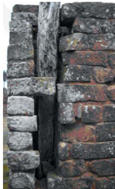
Fig. 12 - Columna esquinera perteneciente a una de las "casas de indios". Santísima Trinidad, Paraguay.
