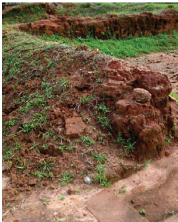
Fig. 13 izq. Restos de muros de adobe existentes en la Misión de Jesús de Taravangüe, Paraguay. Se ve el típico deterioro de la estructura por exposición a la lluvia.
