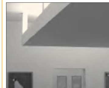
Iluminación disimulada a través de plafones o techos falsos con cambios de altura
