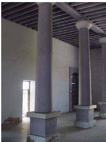
Imagen 47. Vestíbulo de Edificio de Acceso Cementerio el Cuadrado.
