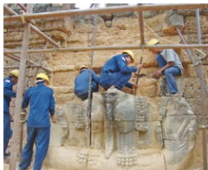
FIGURA 6. Trabajadores locales desmantelan la Garuda #70 en el templo Preah Khan. Proyecto Angkor, Camboya (Fotografía cortesía: WMF, 2011). FIGURE 6. Local workers dismantle Garuda #70 in Preah Khan Temple, Angkor Project (Photography courtesy: WMF, 2011).
