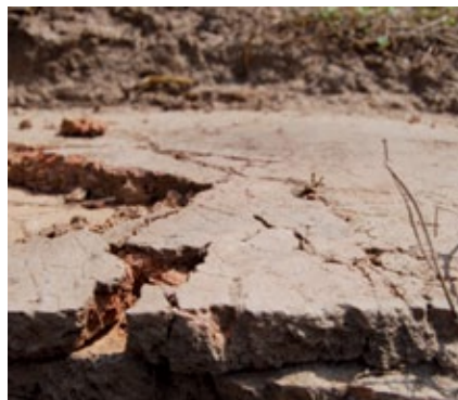
FIGURA 4. Detalle de la serie de capas de revoques que protegen las estructuras (Fotografía: Luis Guerrero, 2009).
