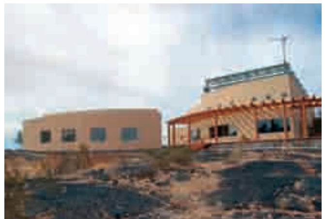
FIGURA 3. Centro de Visitantes Schuk Toak ; se aprecia el generador eólico y los paneles solares (Fotografía Demián Ortiz, 2011).
