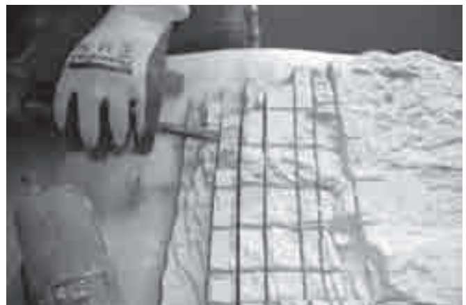
FIGURA 5. La eliminación del mortero debe realizarse por capas; de esta forma, se controlan las vibraciones emitidas a la cerámica, evitando fisuras o fracturas en el material (Fotografía Montse Agüero Duran 2010, cortesía: ABAC).
