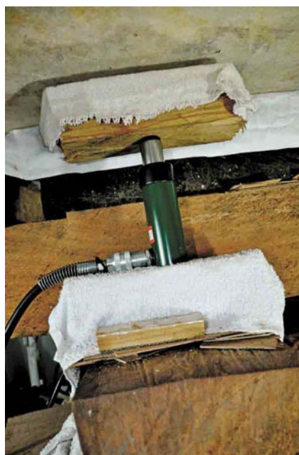
FIGURA 4. Sistema hidráulico utilizado para el movimiento de alzado de lápida, con la asesoría del Ingeniero Roberto Sánchez del Instituto de Ingeniería de la UNAM. (Fotografía: Rogelio Rivero. Cortesía de Proyecto de Conservación Cripta Pakal 2010, CNCPC-INAH).
