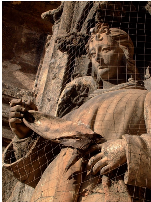
Figura 5 (izquierda). Red utilizada para cerrar los vanos superiores de la portada gótica de la catedral de Huesca. Figura 6 (derecha). El mantenimiento es esencial para evitar la rotura de las redes de protección.
