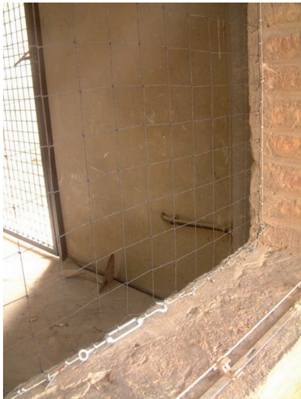
Figura 5 (izquierda). Red utilizada para cerrar los vanos superiores de la portada gótica de la catedral de Huesca. Figura 6 (derecha). El mantenimiento es esencial para evitar la rotura de las redes de protección.
