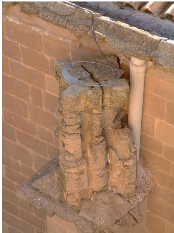
Figura 1 (izquierda). Al efecto estético negativo que provocan los excrementos de aves se une su capacidad de producir graves alteraciones en los materiales.
