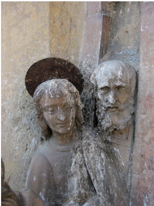
Figura 1 (izquierda). Al efecto estético negativo que provocan los excrementos de aves se une su capacidad de producir graves alteraciones en los materiales.
