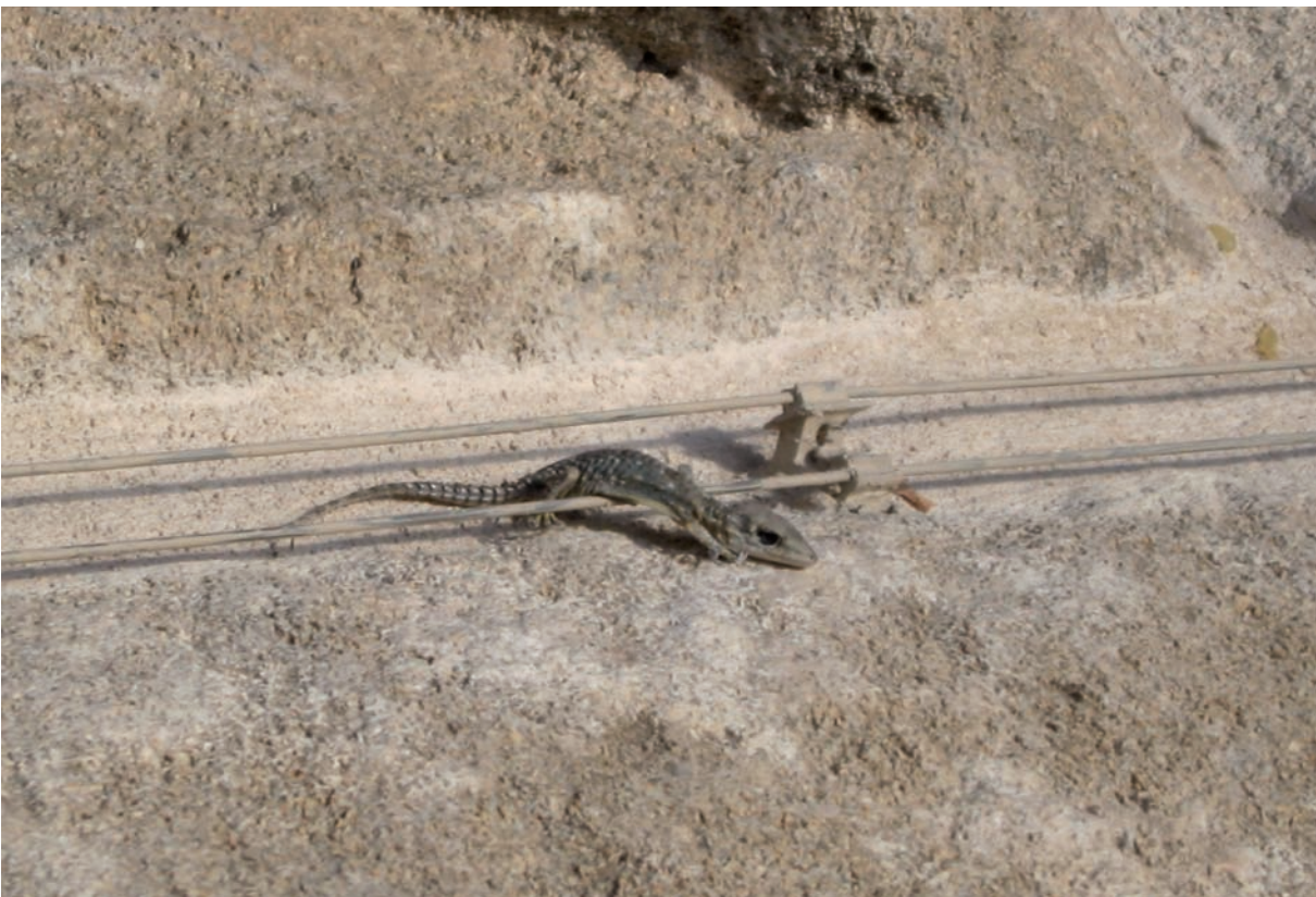
Figura 11. La suciedad o la presencia de pequeños animales provoca cortacircuitos e inutiliza el sistema.
