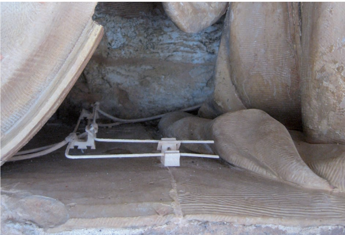
Figura 9. Soporte de policarbonato anclado a la unión de dos planchas de terracota.
