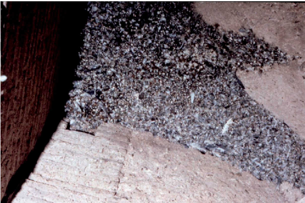
Figura 5. Depósito de plumas y excrementos en un monumento de Rodilana (Valladolid).
