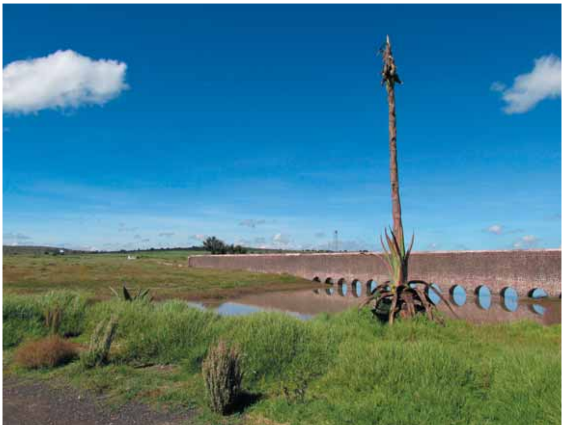
Aspecto de la arcada sólida y el sifón del sitio de Guadalupe.
