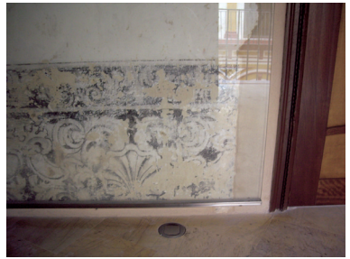
Fig.93. Casa Arizón (detalle pinturas). Sanlúcar de Barrameda. (Cádiz).
