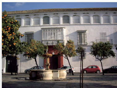
Fig.94. Casa Moreda. Sanlúcar de Barrameda (Cádiz).
