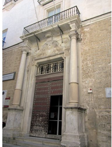
Fig.85. Puerta del Palacio de los Marqueses de Recaño. Cádiz.
