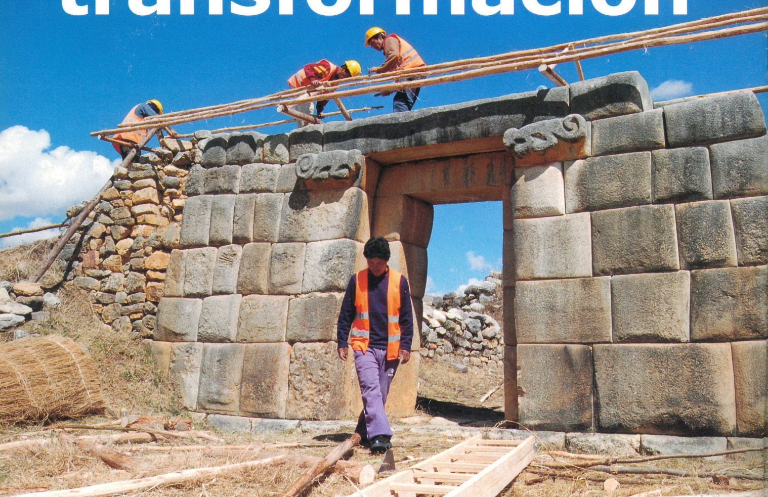
Armado de estructuras para la colocación de techo con ichu.
