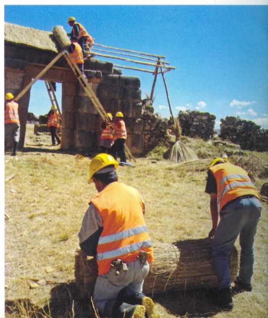
Armado de estructuras para la colocación de techo con ichu.
