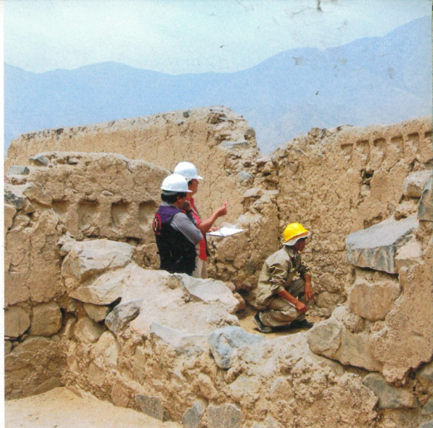
Consolidación de muros en Huaycán de Cieneguilla.
