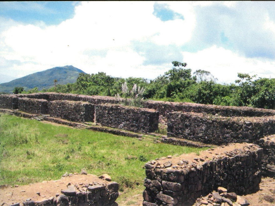
Kallanka en Aypate, Piura. Tramo binacional Aypate - Las Limas, Ecuador.
