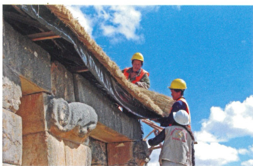
Trabajos de conservación en Huánuco Pampa, Huánuco.
