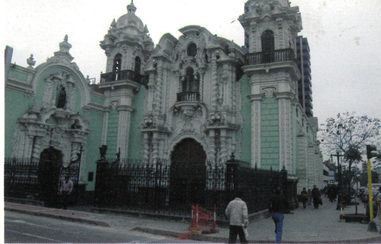
El pequeño templo barroco de San Marcelo, en la avenida Emancipación, mostró pocos daños estructurales, aunque convendría tomar nuevas medidas para su evaluación técnica.
