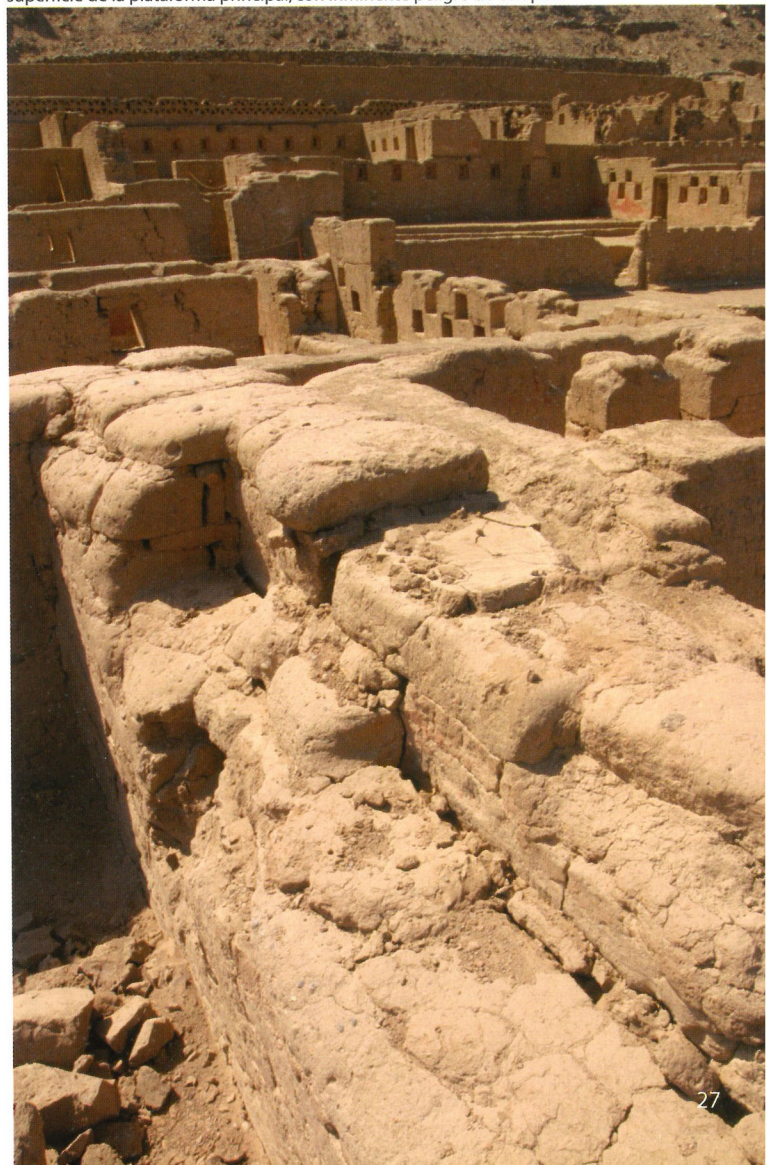
El daño mayor en Tambo Colorado se percibe en las fisuras aparecidas en la superficie de la plataforma principal, con inminente peligro de colapso.
