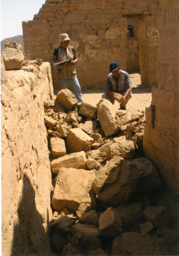
Galerías y pasadizos de Tambo Colorado han sido los más afectados.
