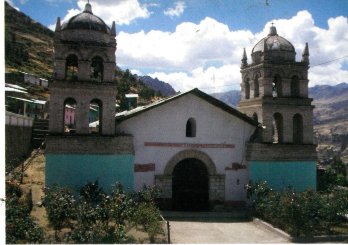
Iglesia de Chupamarca, reconstruida en 1815, también resultó afectada en el sismo.
