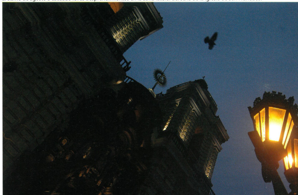
El sismo de agosto causó leves desprendimientos en la zona lateral derecha de la iglesia de San Francisco.
