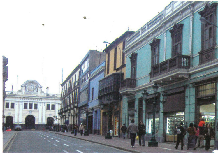
El antiguo hotel Comercio, ubicado al final de esta calle, frente a la Estación de Desamparados requiere una intervención urgente de apuntalamiento, consolidación y restauración.
