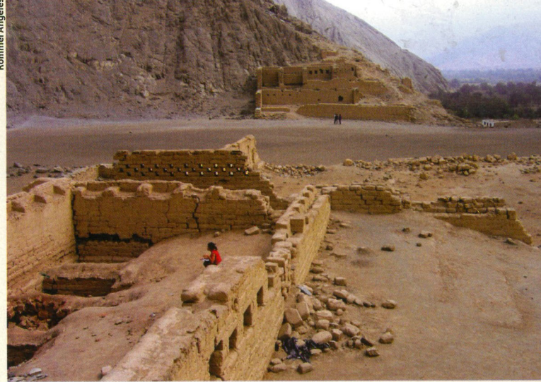
Los habituales problemas del sitio de Uquira, como por ejemplo que es atravesado por una pista, empeoraron con la caída de sus muros tras el terremoto.
