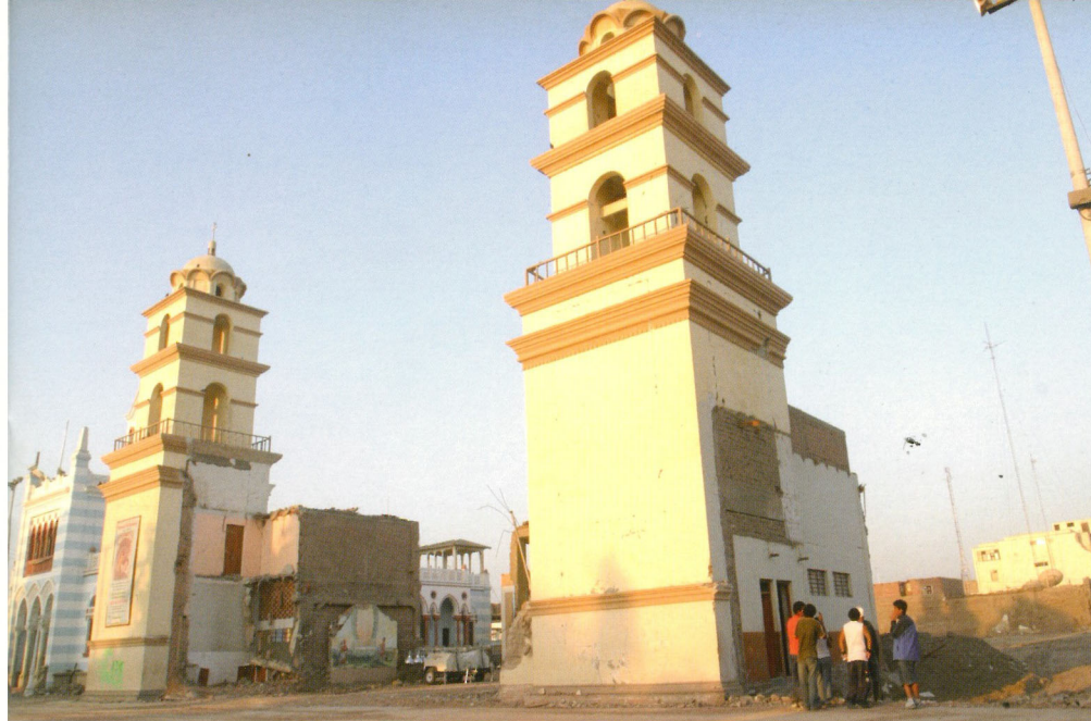
Estado actual de la iglesia de San Clemente. Sólo quedaron en pie las dos torres.
