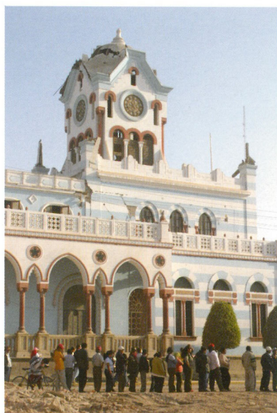
Edificio del municipio de Pisco solo registró daños en una de sus cúpulas y en áreas interiores.
