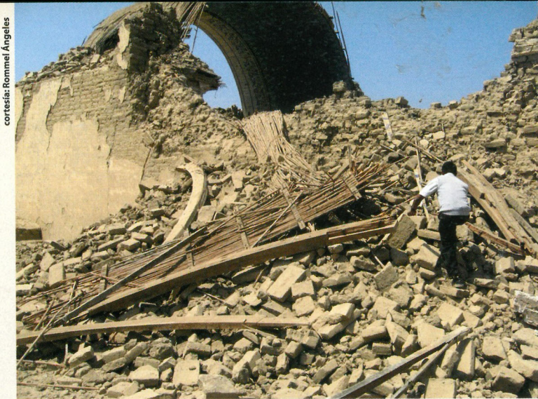
La zona cercana al pórtico renacentista, una de las de mayor valor de la estructura de San Pedro, no consiguió resistir el sismo. Afortunadamente, el pórtico se salvó.
