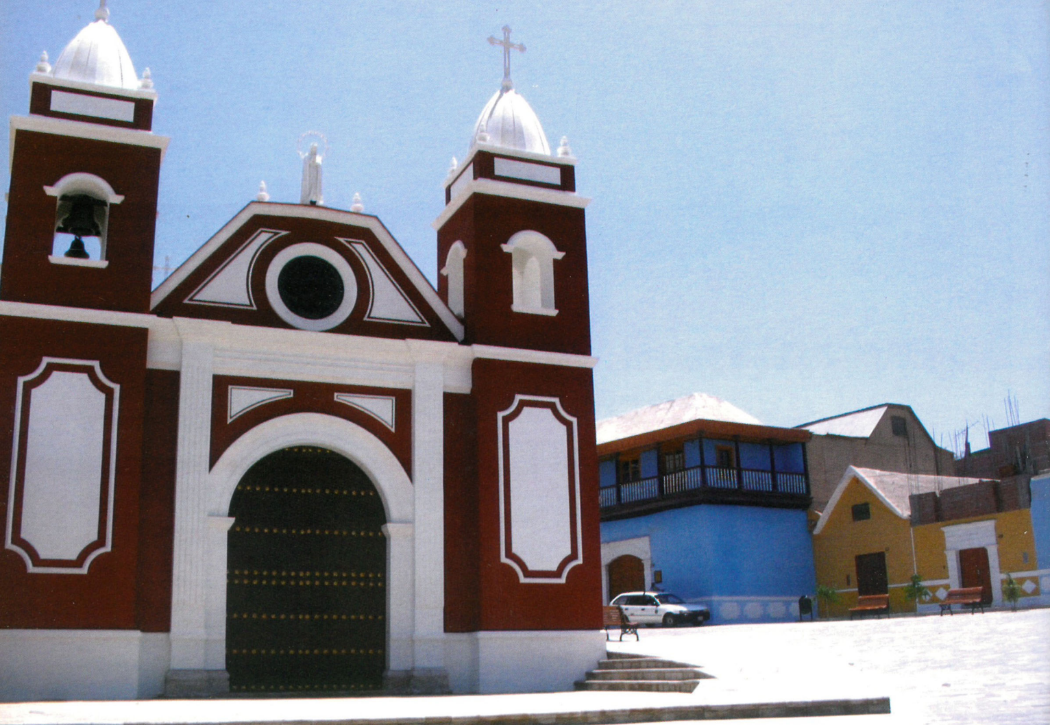
Tras varios meses de trabajo, restaurada iglesia de Belén.
