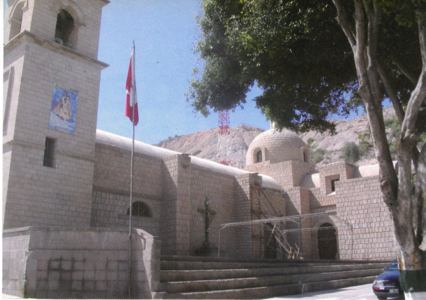
El poblado de Torata, se ve beneficiado con la restauración de su iglesia gracias al buen uso del canon.
