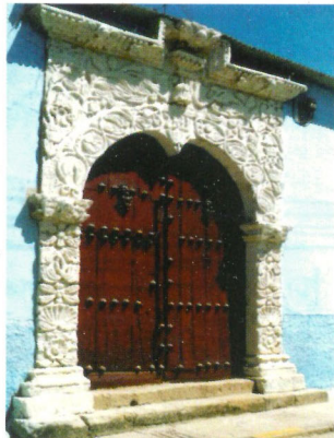
Restaurado. Portón típico del Centro Histórico de Moquegua.
