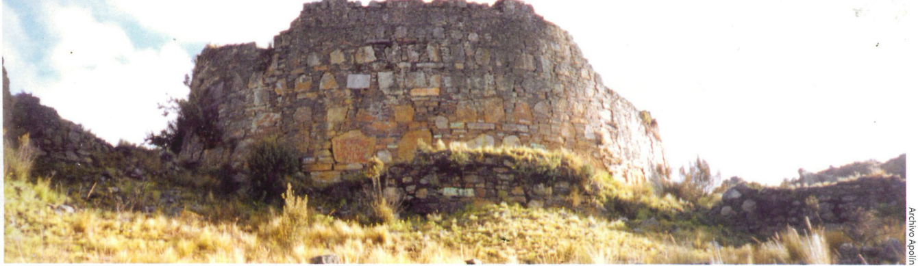
Hay edificios circulares llamados torreones, como la Torre de la Luna. Hay más de treinta construcciones de este tipo.
