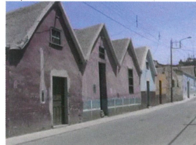
Casas tradicionales del barrio de Belén antes y después de la intervención del INC.
