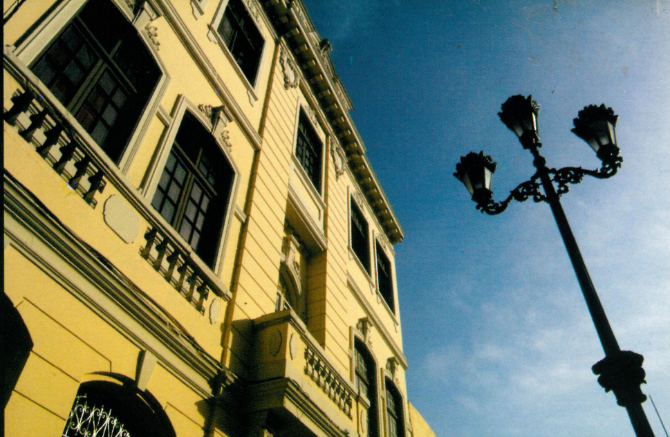
Muestra de la recuperación de la imagen urbana en el jirón Contumazá.
