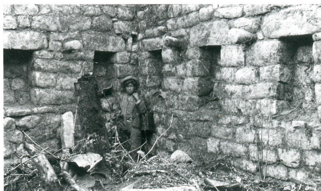
Casa con múltiples nichos, los cuales, suponía Bingham, se utilizaban como poyos y depósitos.
