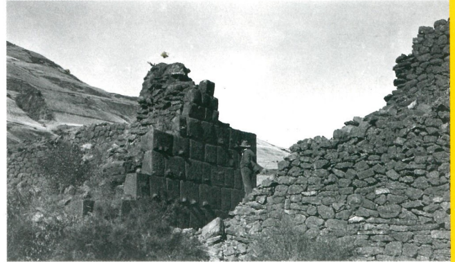
La arquitectura de Rumi Colca muestra dos diferentes tipos de construcción.
