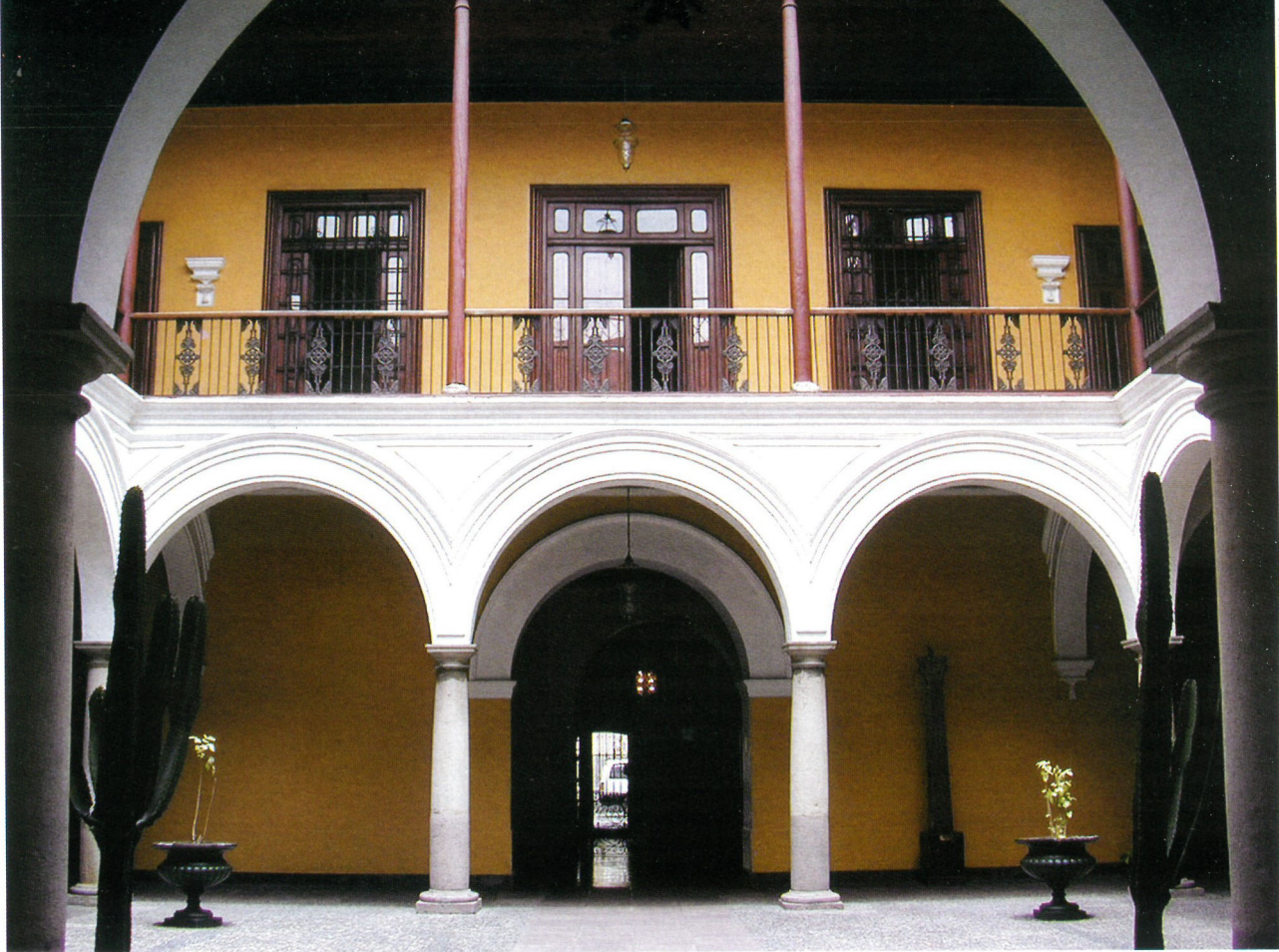
Remozado patio interior de la Casa Píllatos, antiguo local de la Casa de la Cultura del Perú y del INC en el jirón Ancash.
