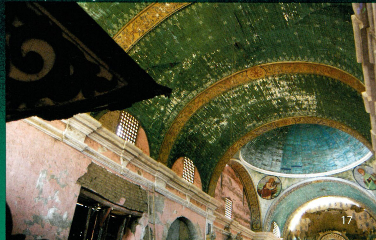
La nave presenta una bóveda de medio cañón. Está revestida por un entablado que contiene figuras sobre un fondo verde azulado.
