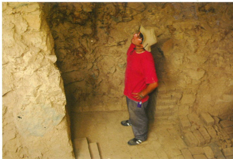
El tamaño de la habitación donde se realizan los primeros trabajos es bastante amplio. Nótese los adobitos en la parte baja.
