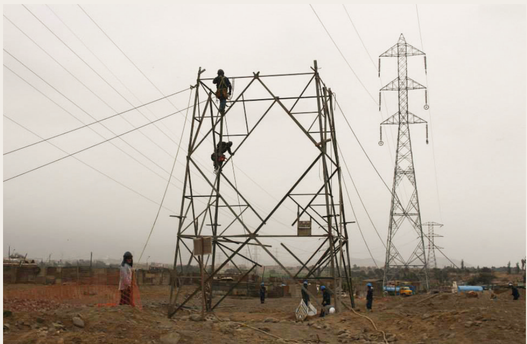
RECUPERACIÓN. Se desmanteló y retiró totalmente una torre de alta tensión.
