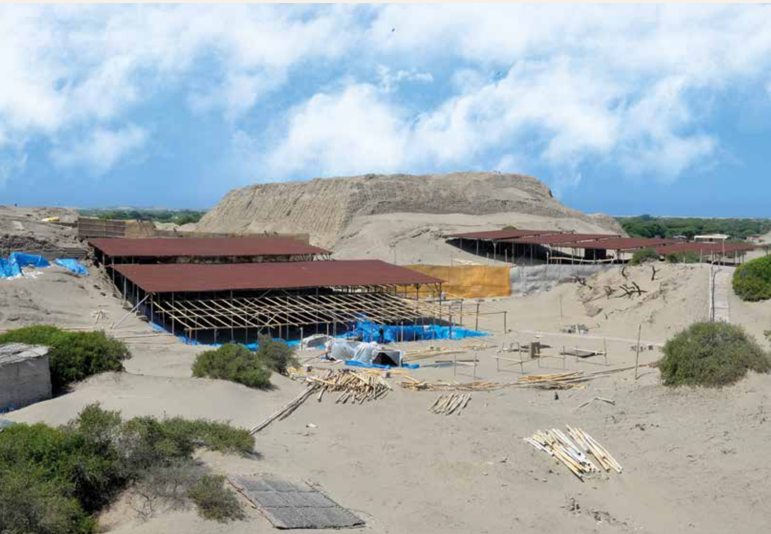
PROTEGIENDO. Instalación de cubiertas provisionales en la Huaca Chotuna, Lambayeque.
