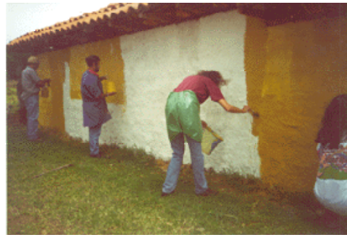
Foto 1: Taller para escolares sobre la técnica del bahareque, los niños realizan el proceso de repello de una pared externa del Museo.
