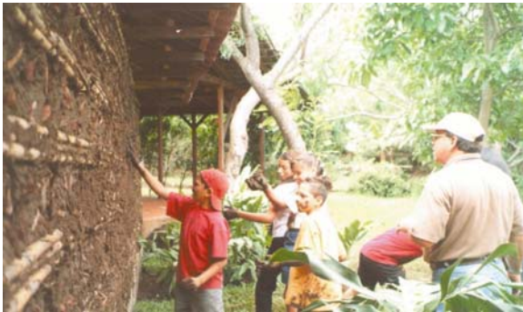
Foto 1: Taller para escolares sobre la técnica del bahareque, los niños realizan el proceso de repello de una pared externa del Museo.
