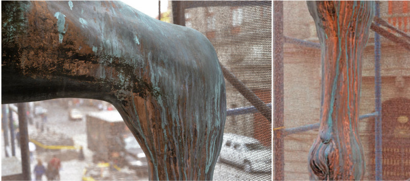
Figura 4. Arriba: Detalles de diferentes zonas de la superficie dañada: atacada con formación reciente de óxidos de cobre, diferentes productos de corrosión verdes, principalmente nitratos de cobre. Abajo a la izquierda y centro: zonas parcialmente afectadas que muestran restos de pátina de corrosión, restos de capa de protección y hollín. Abajo a la derecha: límite entre una zona de cuprita y otra cubierta con nitrato de cobre.
