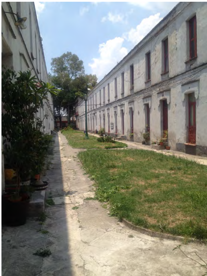
Figura 2. Interior de Privada Alzate 62. Foto: Ángeles Valencia, 2014.
