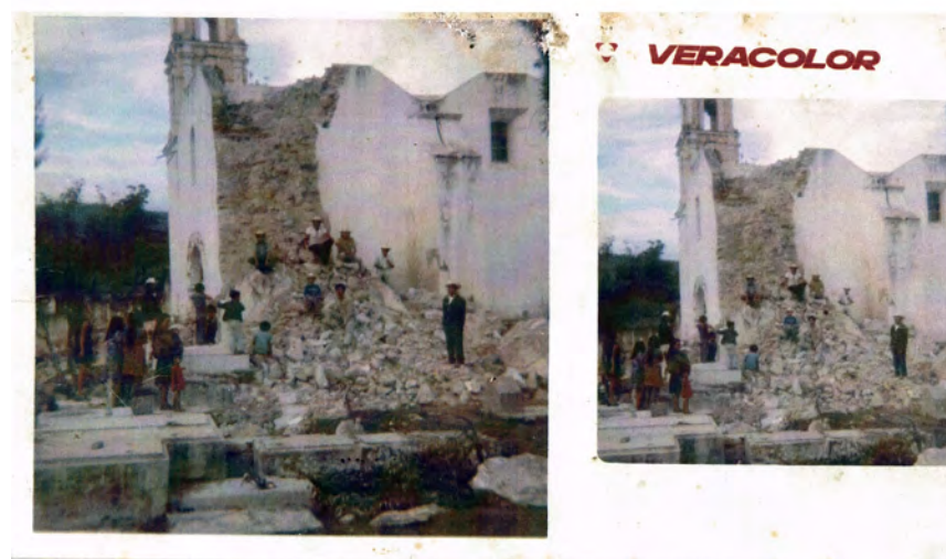
Figura 2. Derrumbe de una de las torres de la iglesia de San Sebastián Villanueva durante el sismo de 1973 (pág. 7).
