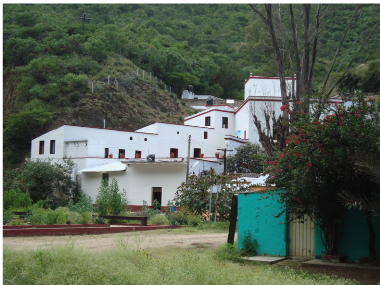
Figura 2. Vista general del Parador turístico, después de su intervención y rescate. Se pueden observar los diferentes niveles de construcción que desde su origen aprovecharon el terraplén del cerro, porque no existía terreno plano para construir. El espacio que se aprecia al frente es el derecho de vía, de frente a la estación del ferrocarril
