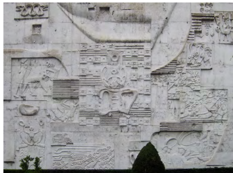
Figura 7. Antes de la intervención 2010
