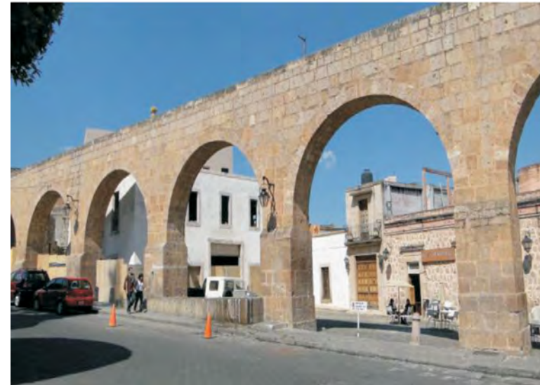
Figura 3. Estacionamiento Villalongín. Intervención final. Carlos Hiriart Pardo, 2011.
