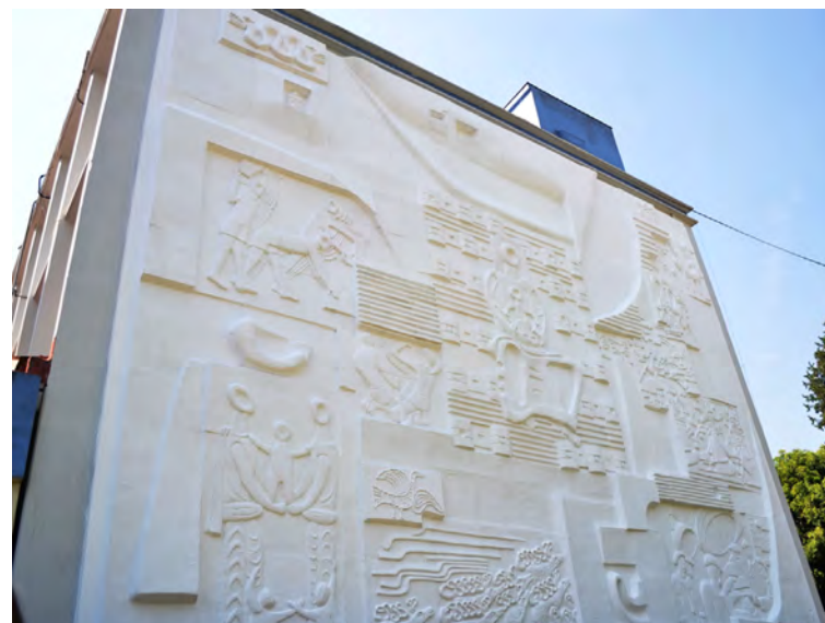
Figura 8. Después de la intervención 2012
