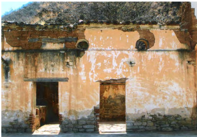
Figura 4. Los muros se mantenían en pie, con la pérdida de aplanados mostraban los materiales con que fueron edificados. Las dimensiones espaciales se mantuvieron sin modificación, y aunque se adecuó la cocina, la hornilla original se conservó como testimonio de las actividades en esta área de la vivienda. Obsérvese la calidad de construcción y el sistema constructivo; los muros de carga desplantados con piedra, se continuaban con gruesos adobes para rematarse con tabique y terminar el muro donde se colocaba la cubierta con madera y teja.
