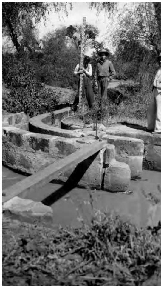
Figura 4. Primer partidor sobre el canal principal, denominado El Molino. A la derecha se ven: la bocatoma del canal de Cincimeo y el canal de El Zapote, y, en el extremo izquierdo, el del Potrero Verde
