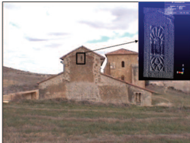
Fig. 5 Ejemplo de selección de la zona de escaneado y nube de puntos capturada.
