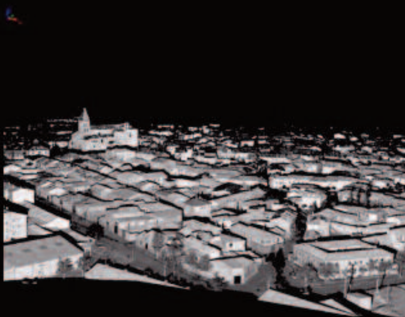
VISTA AEREA DE PAREDES DE NAVA
