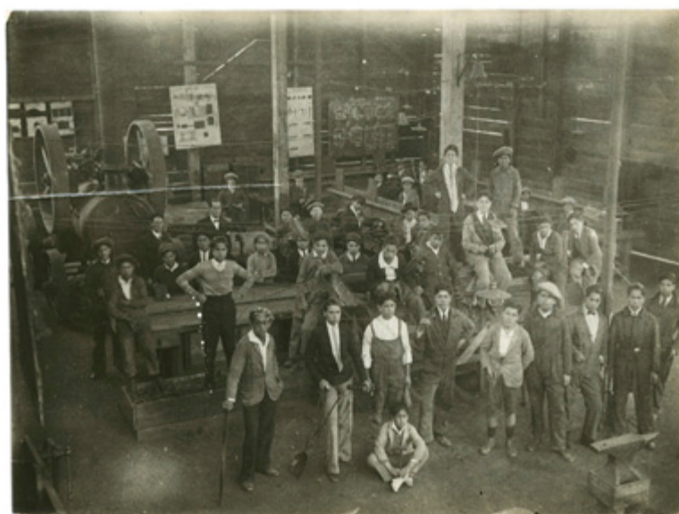
Figura 2. Alumnos al interior del taller de herrería, Escuela de Minas de La Serena (Fotografía: Archivo DGA, 1929).
