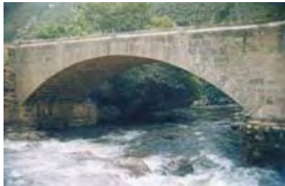
Puente de Zuta, sobre el río Utcubamba, de 11,3 m de largo, hecho de piedra labrada por los propios pobladores. José Tulio Culqui Velásquez
