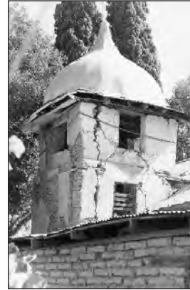
Fracturas con compromiso estructural (*).
