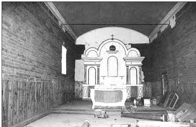
Nave Central, antes de la restauración (*).
