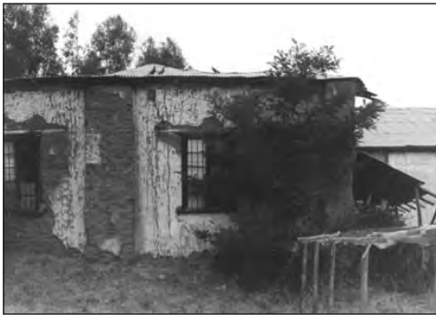
Árboles al pie del muro (*).
