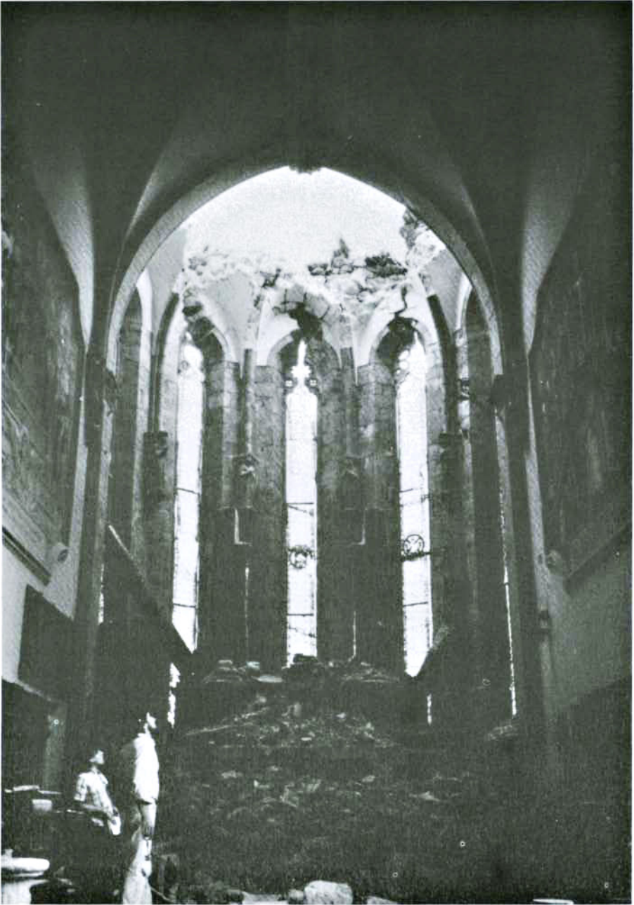
Fig.2 Catedral de Venzone, Friuli, después del sismo del 6 de mayo de 1976.
