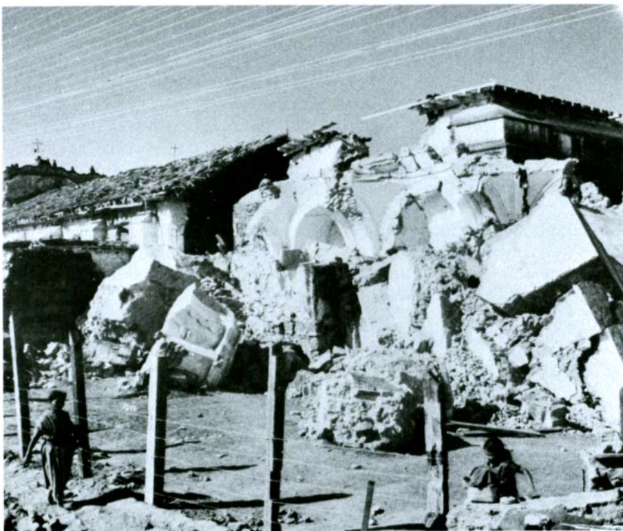
Fig. 7 La sacristía de Patzún, Guatemala, reducida a escombros por el sismo del 4 de febrero de 1976.
