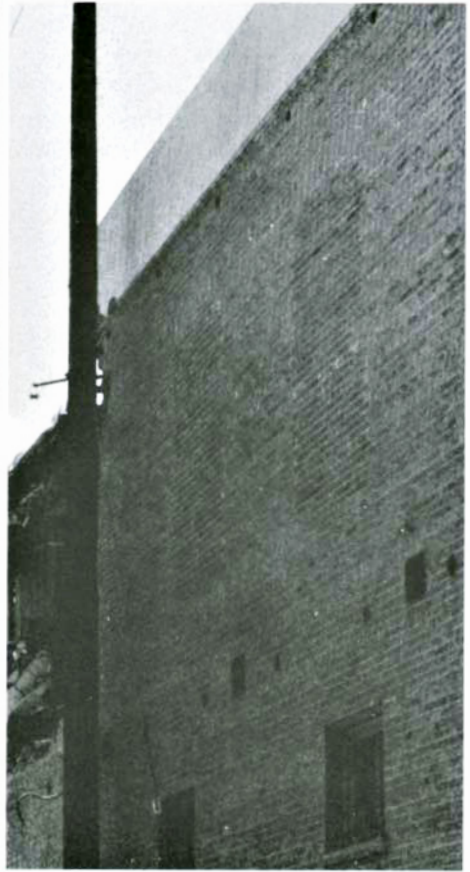
Fig. 15 Arriba: una parte no anclada del edificio colapsa durante el sismo de 1983 en Coalinga. Fotografía de la derecha: el anclaje de las vigas de entrepiso estabiliza el muro.
