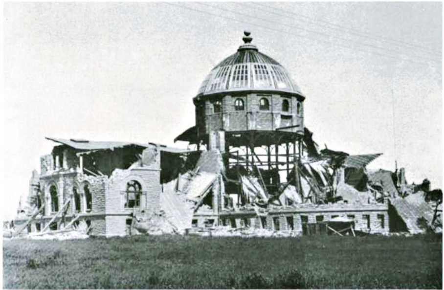
Fig. 17. Arriba: La cúpula de la biblioteca de la Universidad de Stanford poco antes del terremoto de 1906 en Palo Alto, California. Abajo: En vista de la amplitud de los daños sufridos, se demolió el edificio y no se reconstruyó.
