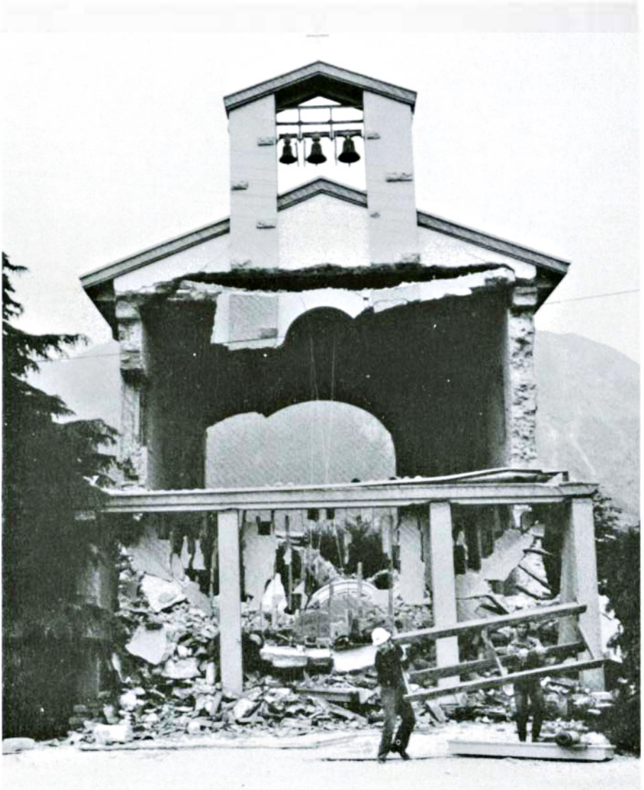
Fig. 11 Techo y campanario que sobrevivieron al sismo de 1976 en Gemona, Italia.
