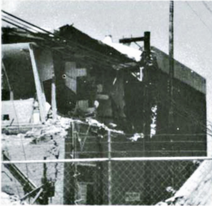
Fig. 15 Arriba: una parte no anclada del edificio colapsa durante el sismo de 1983 en Coalinga. Fotografía de la derecha: el anclaje de las vigas de entrepiso estabiliza el muro.
