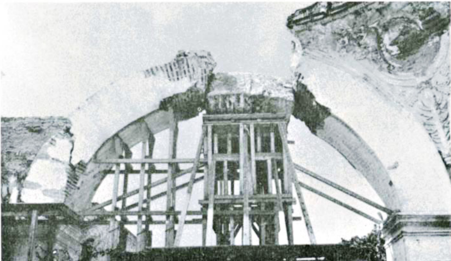
Fig. 16. El arco de San Francisco en Antigua, Guatemala. Un esfuerzo por repararlo después del sismo de 1976.
