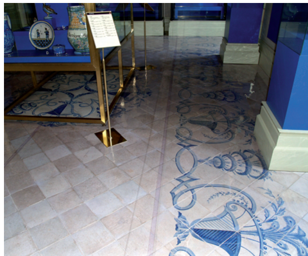
Figura 6. Protección con láminas de PVC con filtro UV tratado en masa en el suelo cerámico de 1867 de la antigua biblioteca del Palacio, en la segunda planta. Foto: Museo Nacional de Cerámica y de las Artes Suntuarias "González Martí".
