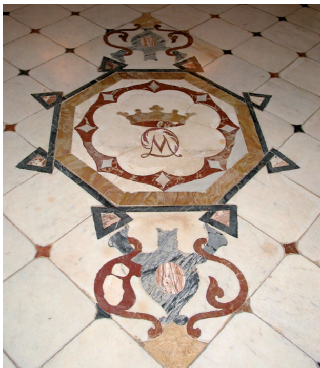
Figura 5. Medallón de sectile del pavimento de mármol de la planta noble. Foto: Museo Nacional de Cerámica y de las Artes Suntuarias "González Martí".
