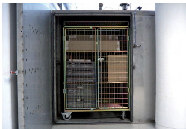
Figura 10. Equipos de nitrógeno para la anoxia de las obras. Foto: Musée du Quai Branly.
