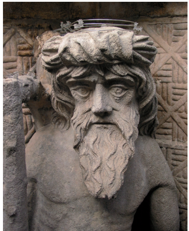
Figura 1. Detalle de una de las esculturas de la fachada de San Gregorio con el sistema antipalomas instalado. Foto: Museo Nacional Colegio de San Gregorio.
