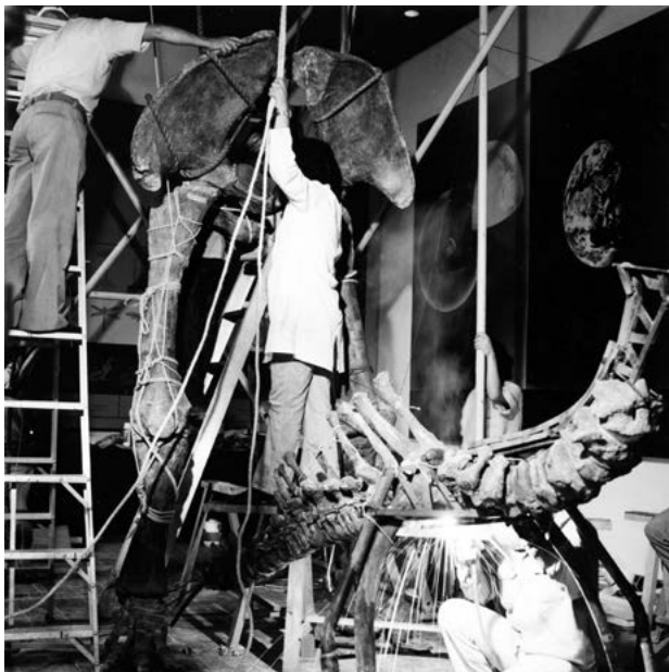
Proceso de montaje de la parte trasera del mamut. En primer plano, soldadura de la estructura de metal en la columna vertebral Fotografía © Fototeca de la CNCPC, álbum Museo Regional de Guadalajara, negativo CXLIX-A-6-4-1, CNCPC-Secretaría de Cultura-INAH
