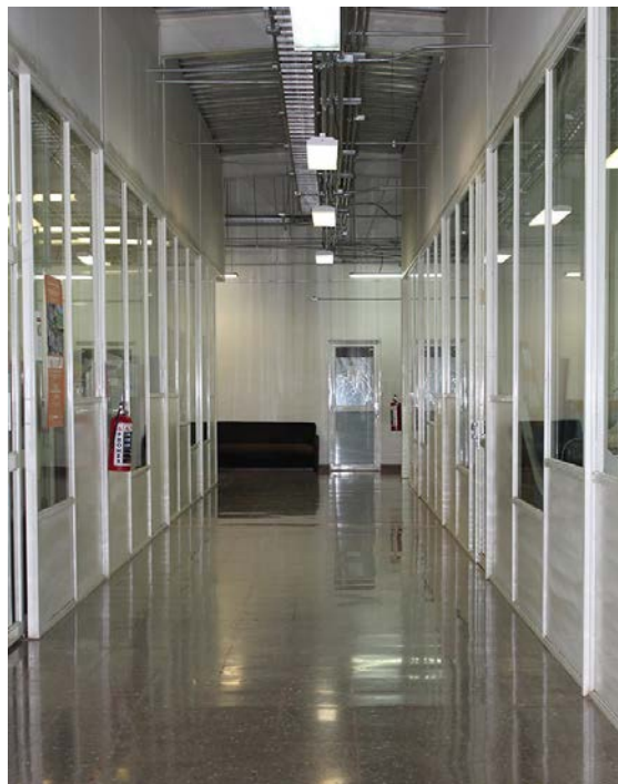
Figura 1. Los pasillos, puertas de acceso a talleres, laboratorios y oficinas, salidas de emergencia, deben estar libres de obstáculos que dificulten la circulación de las personas. Imagen: Bertha Peña Tenorio, ©CNCPC-INAH, 2018.
