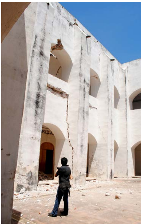
Figuras 2 y 3. Daños observados en la visita de inspección al exconvento de Santo Domingo, Tehuantepec, Oaxaca. A la izquierda, ala oeste del convento. A la derecha, colapso de bóveda en ala oeste, pasillo del 1er piso del convento. Imágenes: Thalía Velasco Castelán, ©CNCPC, 2017.
