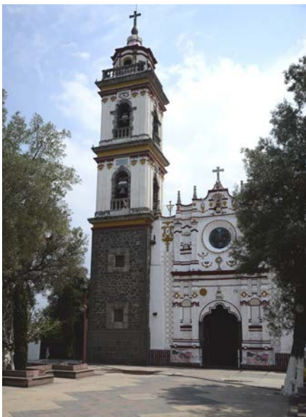
Figura 1. Justo a la izquierda del gran portón de acceso al templo e inmediatamente bajo el agudo campanario. Imagen: ©CNCPC-INAH, 2016.
