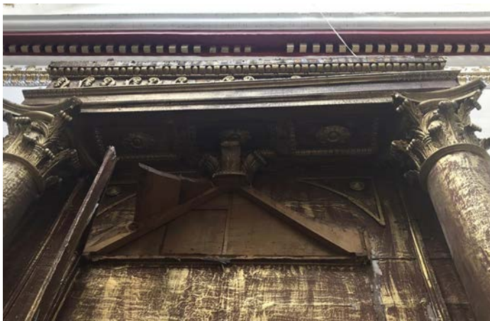
Figura 10. Así se aprecia una fractura del bastidor de entablamento. Retablo colateral de San Agustín Tepexco, Puebla. Imagen: ©Sarahy Fernández García, CNCPC-INAH, 2017.
