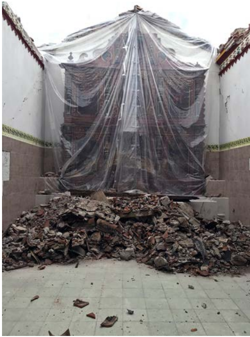
Figura 2. Liberación y protección del retablo principal. Templo de San Jerónimo Tehuantepec Imagen: Salem Ojeda, ©CINAH Oaxaca, 2017.
