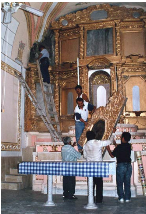
Figura 4. AH-CNCPC. Diagnóstico de daños afectados por el sismo del día 15 de junio de 1999. Parte 2. Imagen: ©CNCPC-INAH.
