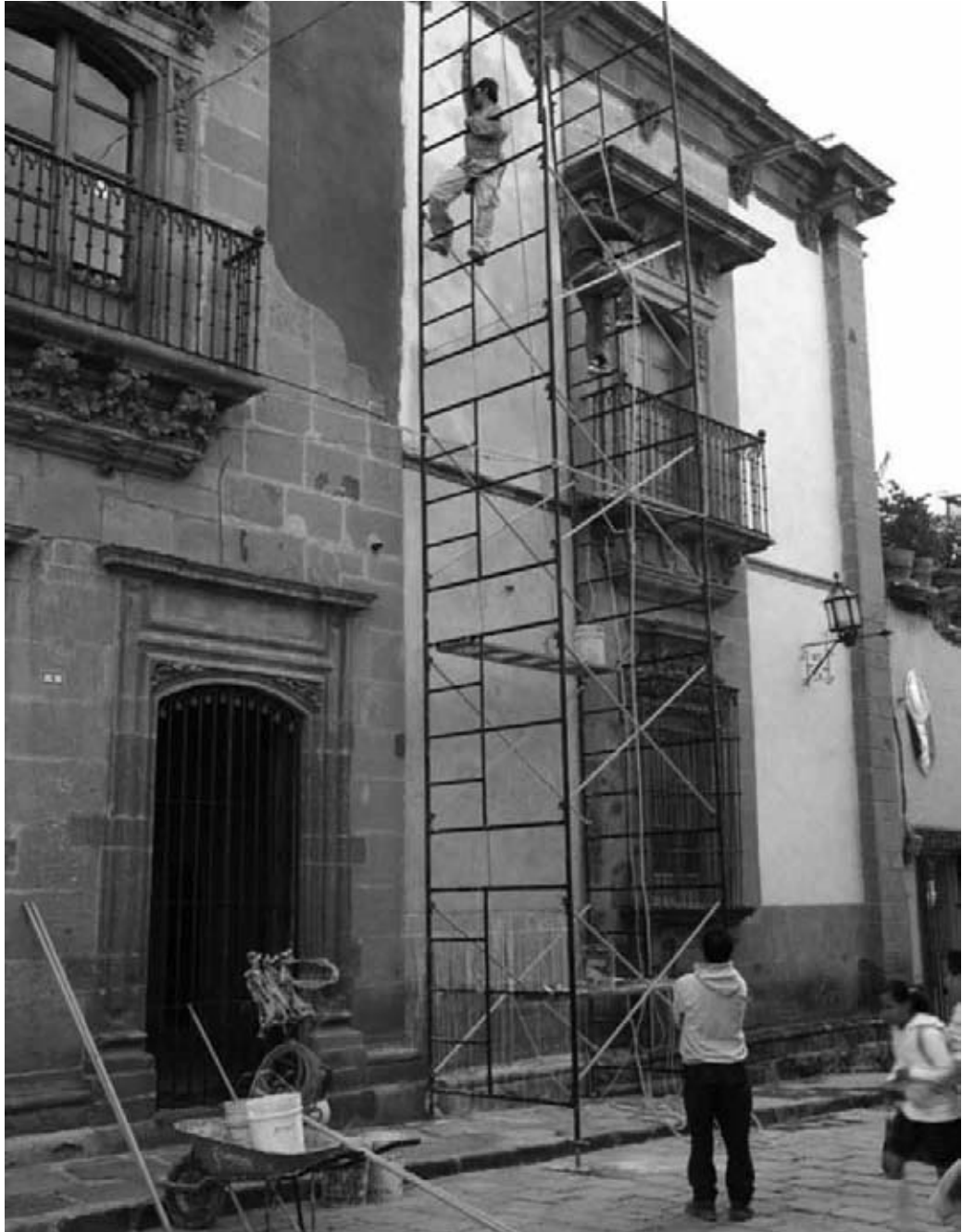
Arreglos de la fachada del Museo Histórico Casa de Allende
